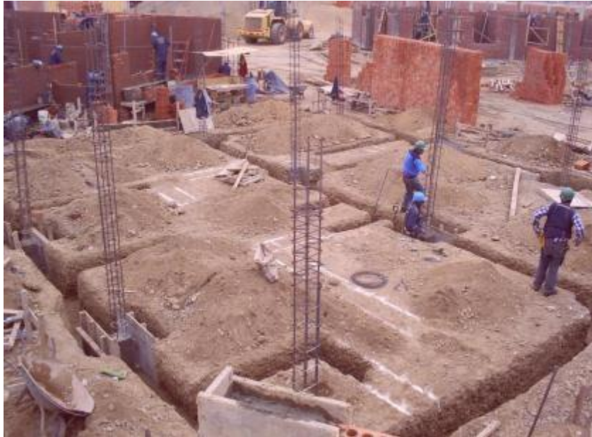
Figura 4 Cimentación de los muros de albañilería.
