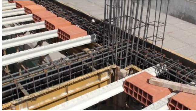
Figura 2 Colocación de elementos prefabricados (viguetas) en losas.
