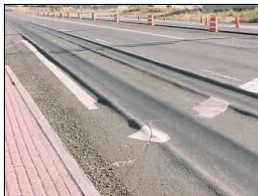
Figura 8. Ahuellamiento.
