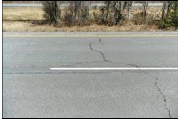
Figura 13. Fisuras transversales.
