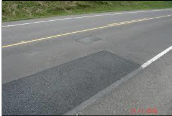
Figura 9. Reparaciones o parchados.
