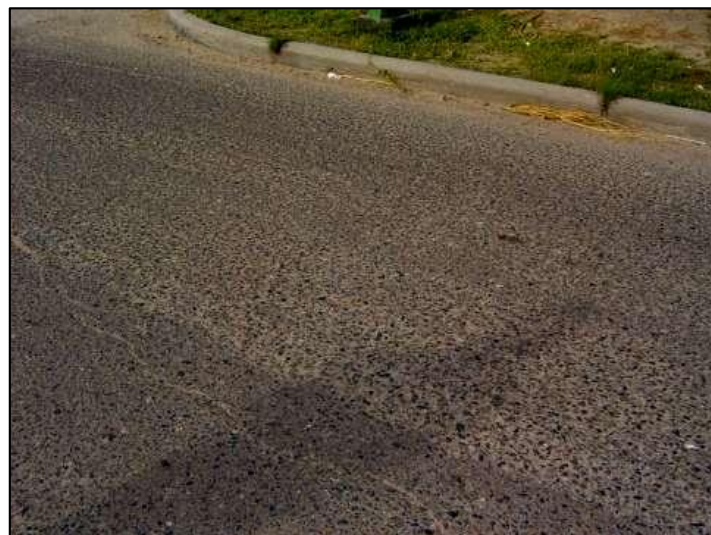
Figura 10. Peladura.
