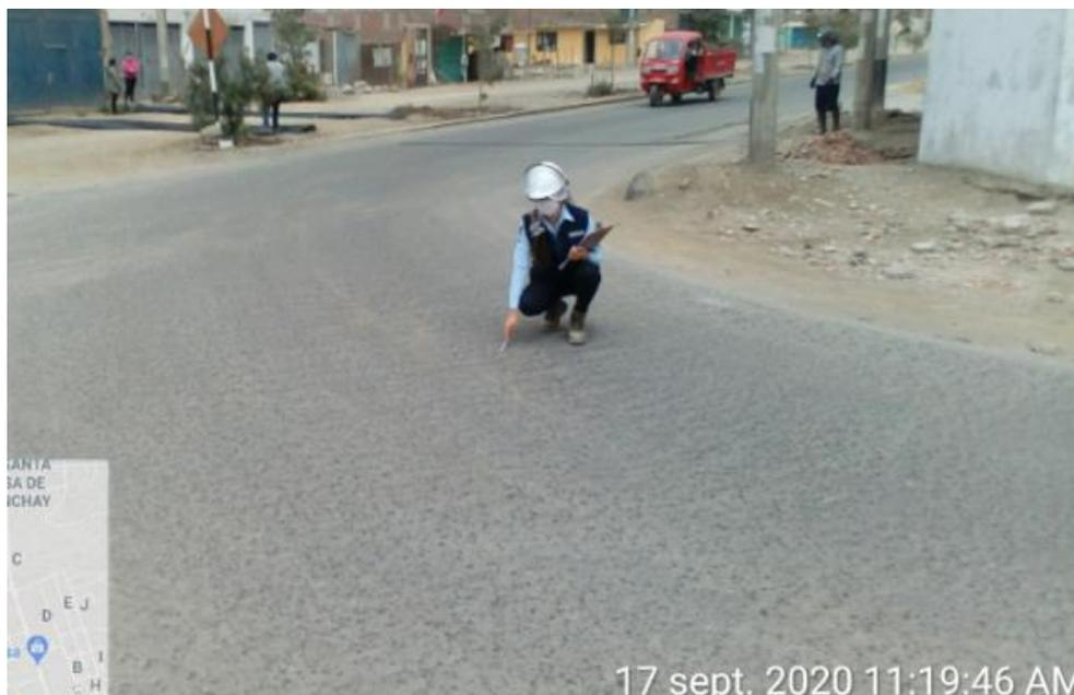
Leyenda: Presencia de fisuras en la progresiva 1+000 de la calzada
