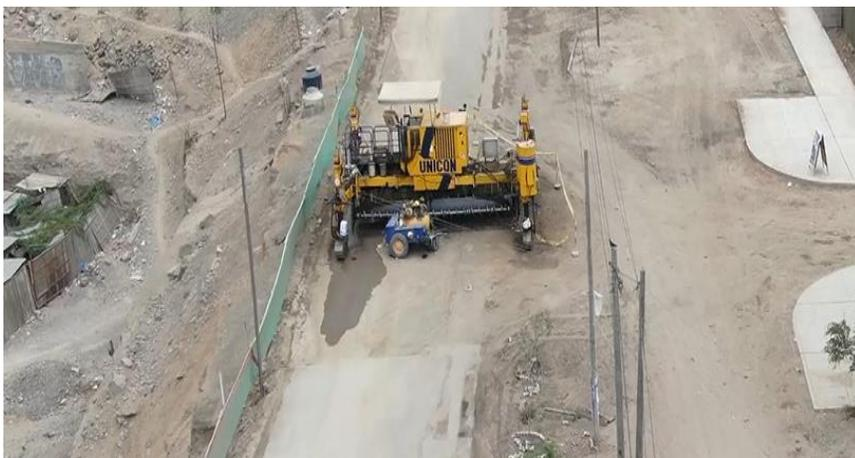
Leyenda: Pavimentadora de 7.20 m de ancho posicionada para pavimentar en la Av. Víctor Malásquez-Manchay
