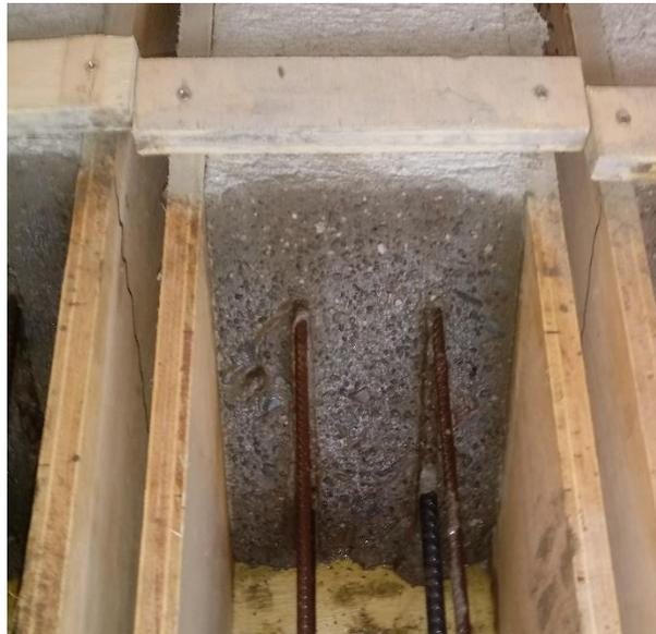
*Figura 14.* Junta de construcción cepillada
