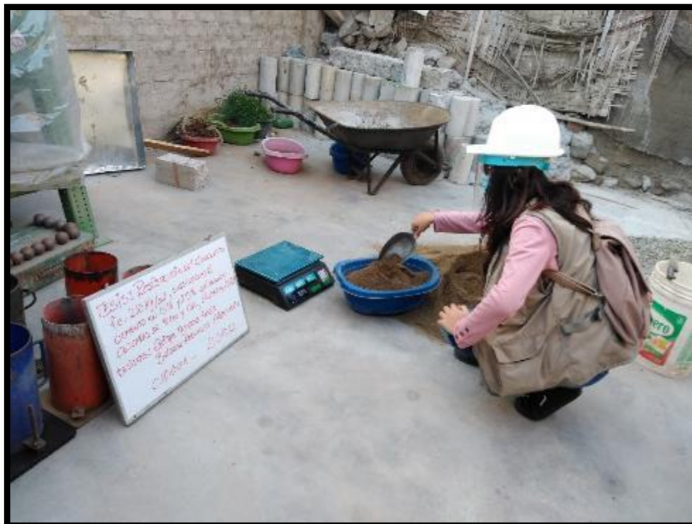
Fotografía 10. Realizando el peso de la arena para la mezcla de concreto.
