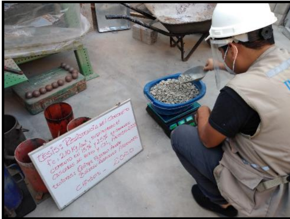
Fotografía 9. Realizando el peso de la piedra chancada para la mezcla de concreto.
