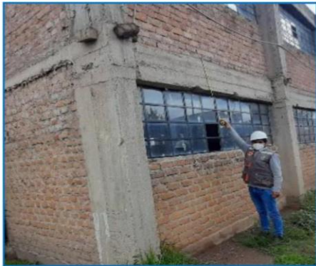
IMAGEN 09: Vistas de mediciones de peralte de vigas y vista lateral de modulo.
