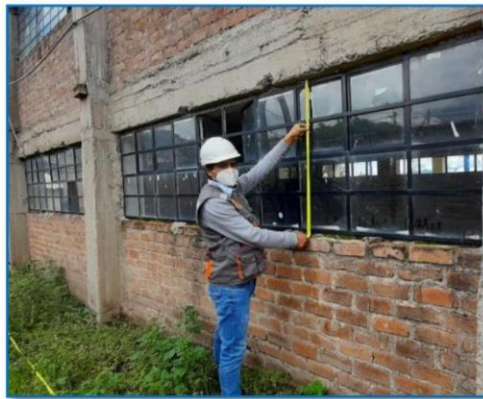
IMAGEN 06: Vistas de mediciones de ventanas de primer nivel.
