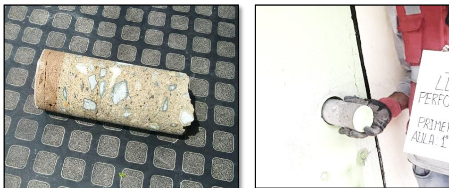
Figura 19: Imagen de muestras de concreto - ensayo de Diamantina. FUENTE: Elaboración Propia.
