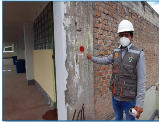
IMAGEN 05: Vistas de puntos para ensayos de Diamantina y Esclerómetro en columnas y vigas.
