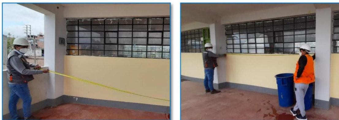
IMAGEN 01: Vistas de mediciones de distancias entre columnas.
