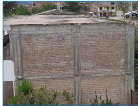
IMAGEN 09: Vistas de mediciones de peralte de vigas y vista lateral de modulo.
