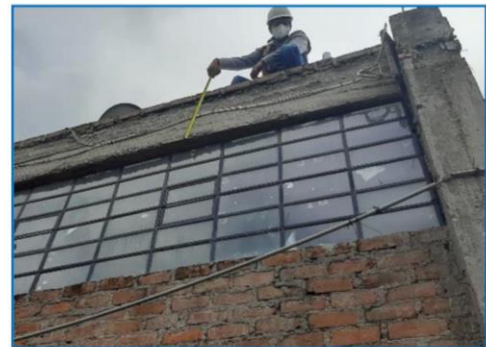
MAGEN 15: Vistas de mediciones de vigas peraltadas longitudinales y trasversales en segundo nivel.
