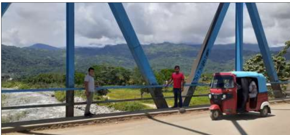
Visita de campo, en la que se aprecia el puente Ejército sobre el río Pichari
