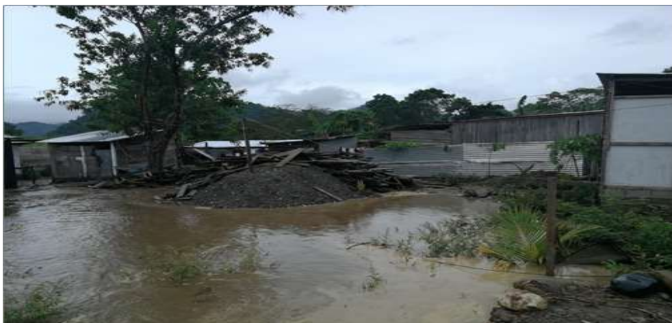
Inundación y desborde del río Pichari que afecto a las viviendas que se encuentran en la margen derecha del río Pichari
