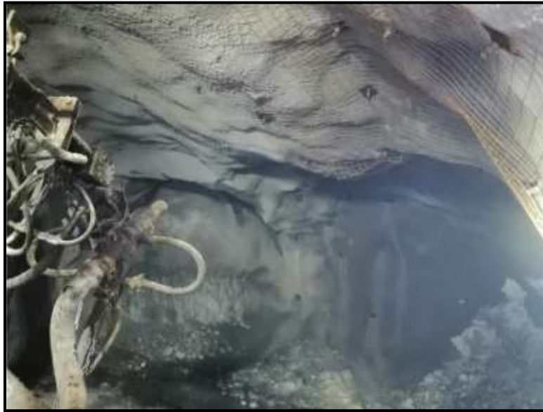
Figura 6. Proyección de shotcrete mecanizado
