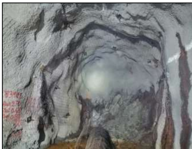
Figura 1. Labor con sostenimiento estructural
