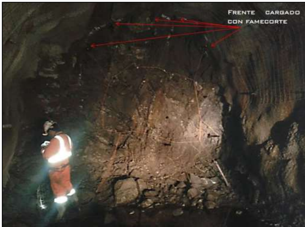
Figura 31. Frente cargado con famecorte
