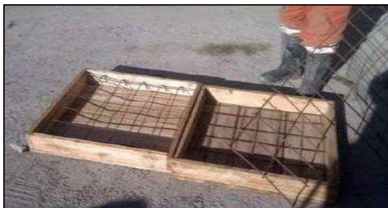
Figura 50. Preparación de paneles
