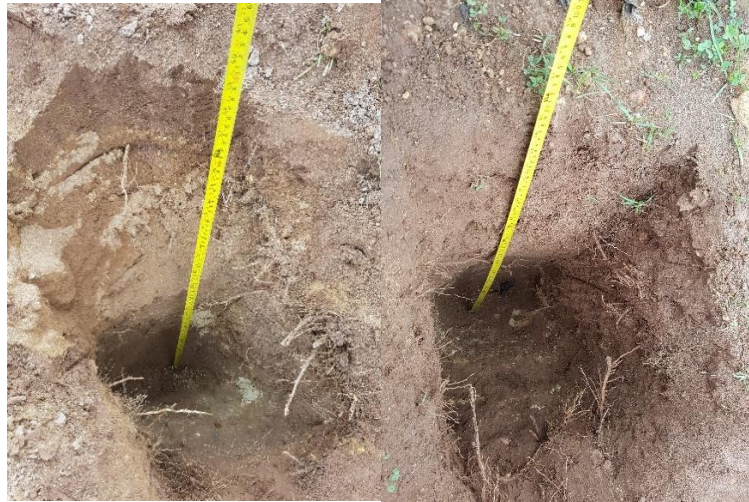
Figura N°2 Excavación del Terreno
