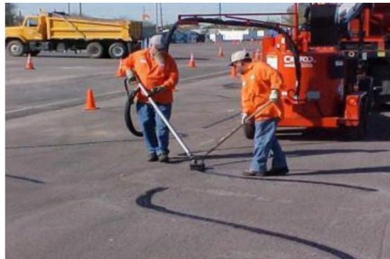
Figura 4: Sellado de Grietas
