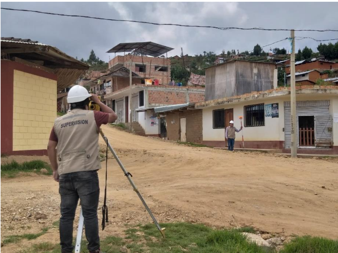
Fotografía 04: Levantamiento de nivel de vereda existente
