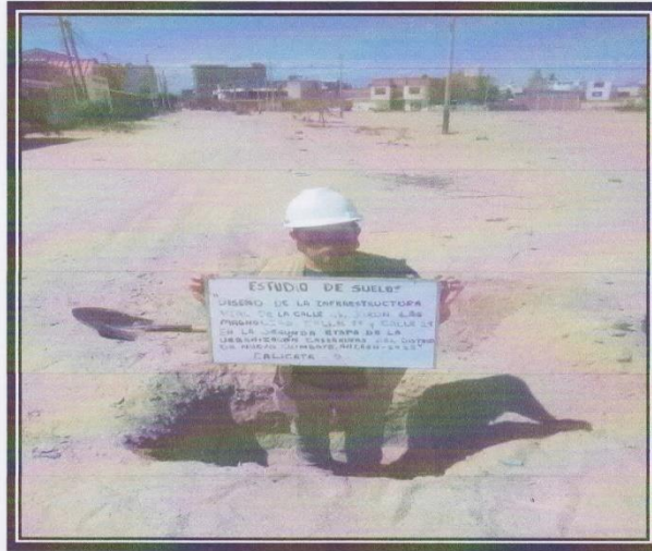
FOTOS N° 01,02: Excavación manual de Calicata N° 01
