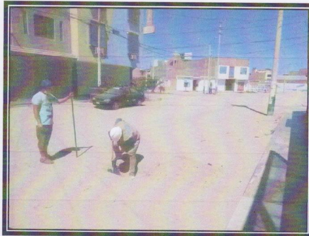
FOTOS N° 05,06: Excavación manual de Calicata N° 03
