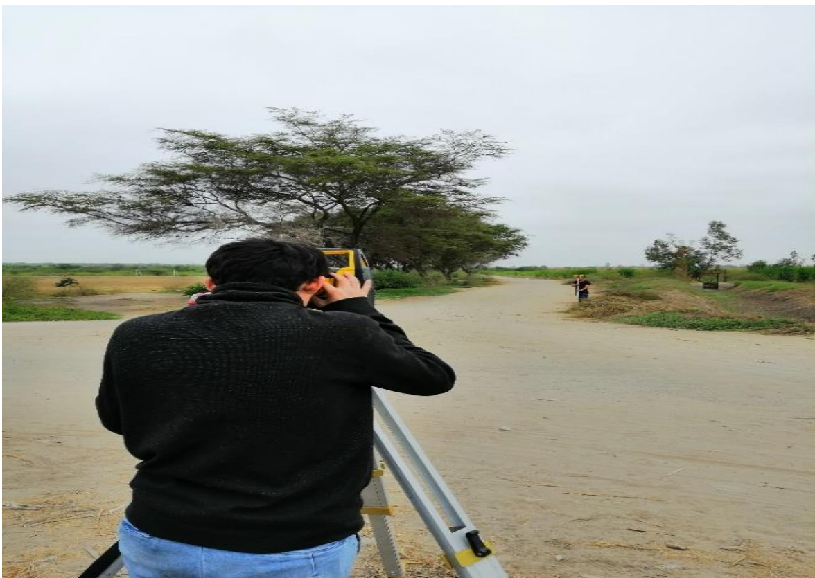
Figura N° 16: Levantamiento topográfico con estación total.
