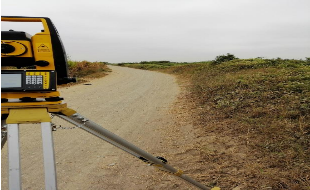
Figura N° 15: Levantamiento topográfico con estación total.
