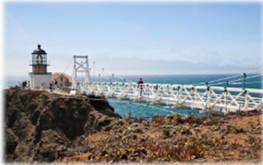
*Figura 6.* Puente peatonal con perfiles de FRP
