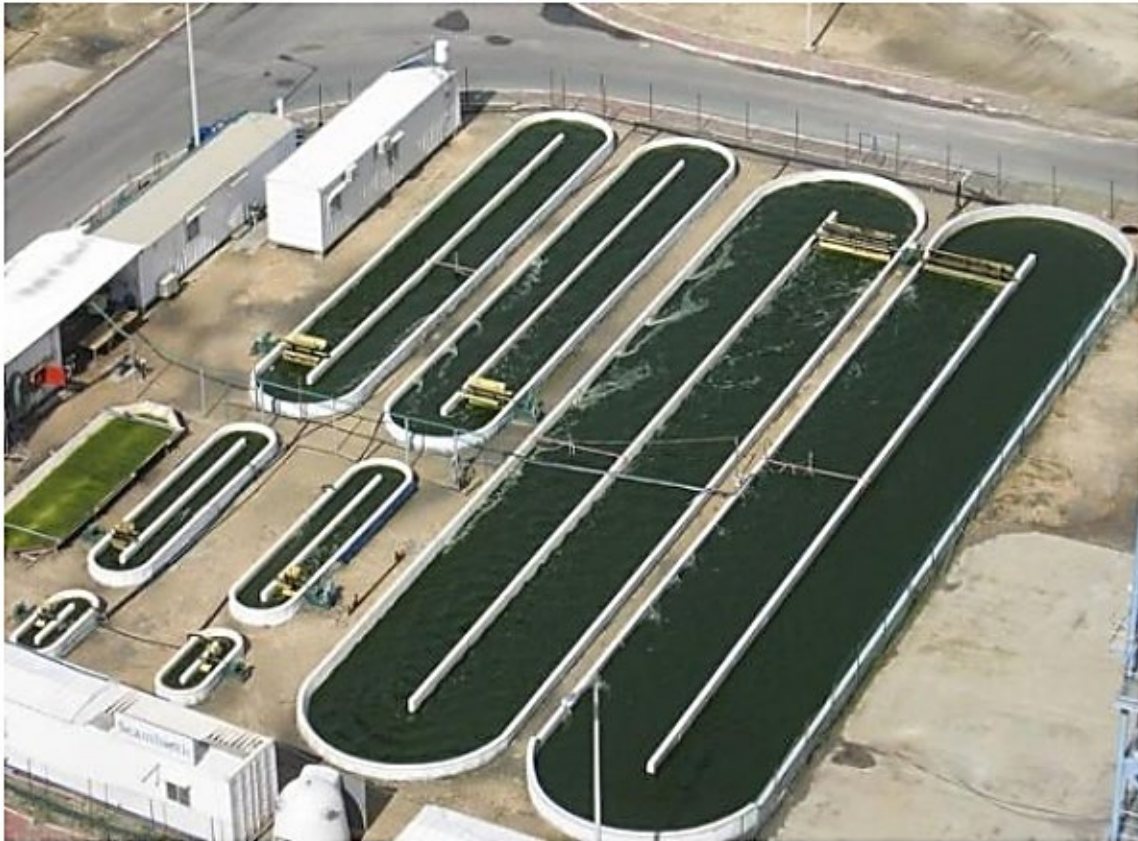
Figura 3. Sistema de estanques abiertos de cultivo de microalgas HRAP de alta velocidad en Israel. Fuente: (Royaux 2018)
