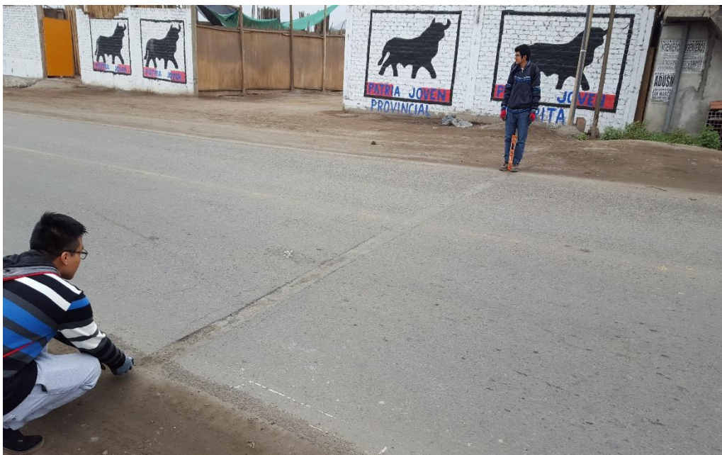
Imagen 7: Medición del ancho de la carretera
