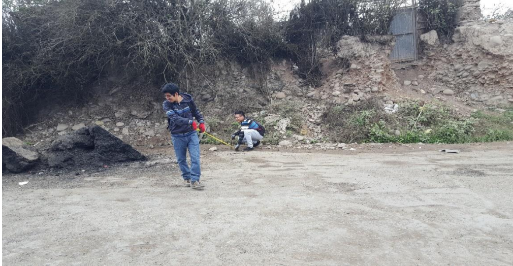
Imagen 5: Falla por bacheo
