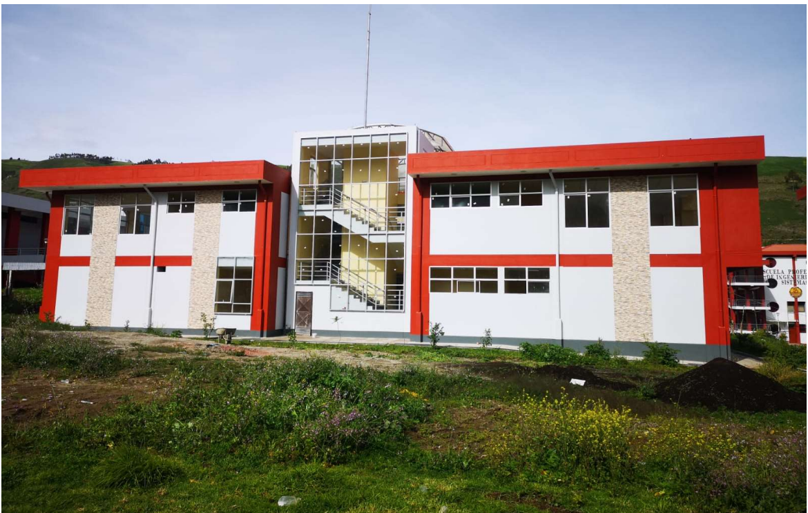
Fotografía 4. Vista posterior del edificio en estudio.
