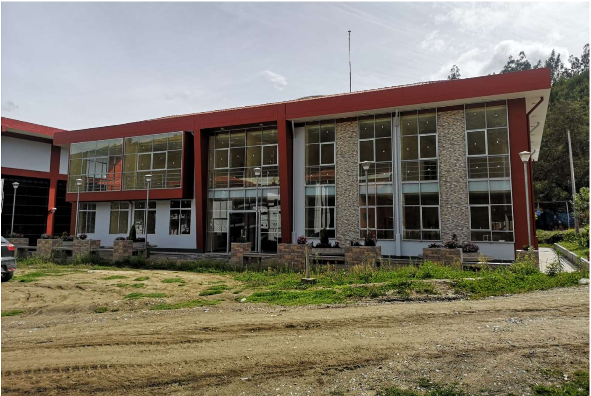
Fotografía 3. Vista frontal del edificio en estudio.
