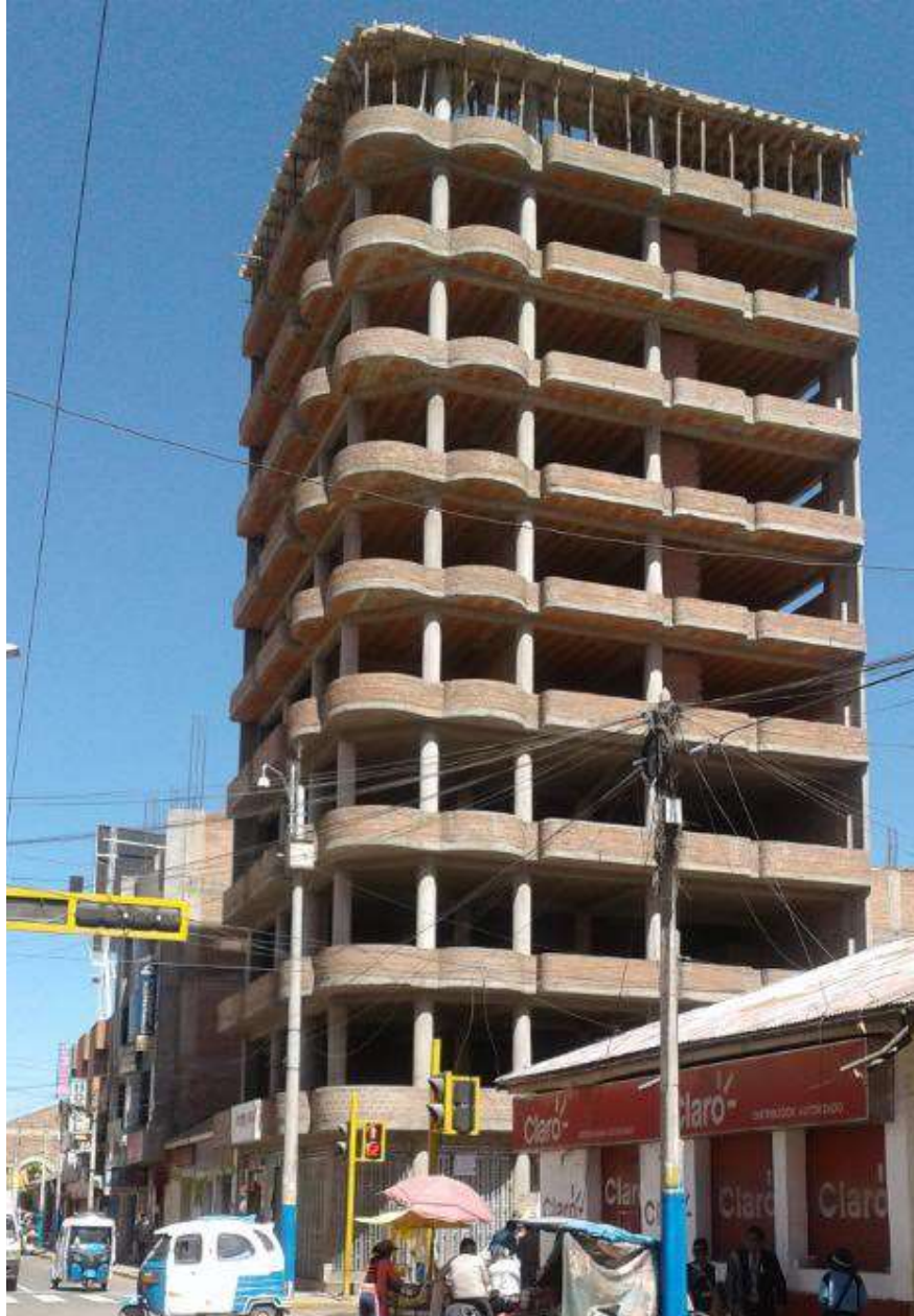
Figura 52. Edificio comercial-hotel en construcción.
