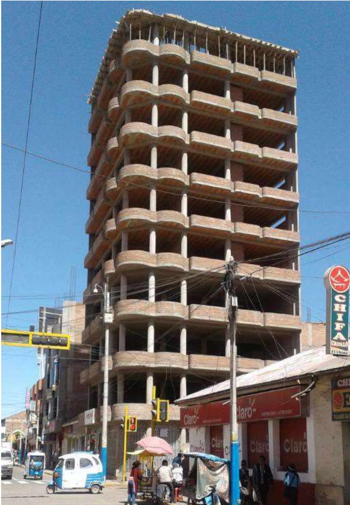
Figura. Edificación Comercial-hotel durante la construcción.
