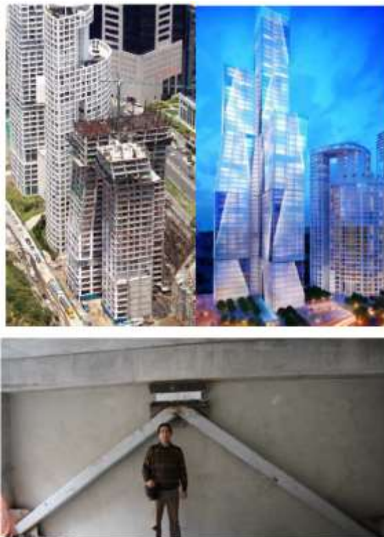
Figura 44. Torre paradox en México con disipadores SLB.
