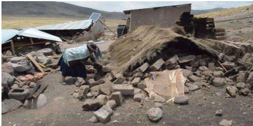
Figura 2. Viviendas dañadas por el sismo ocurrido en Lampa
