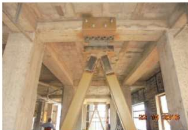
Figura 46. Refuerzo con SLB Edificio Ceibo Dorado (Hotel).
