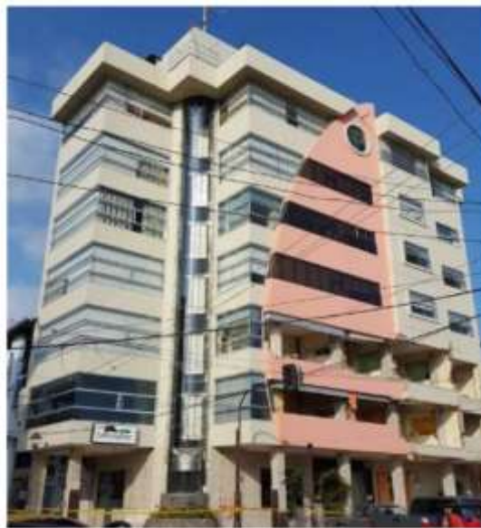
Figura 45. Edificio Ceibo Dorado (Hotel)
