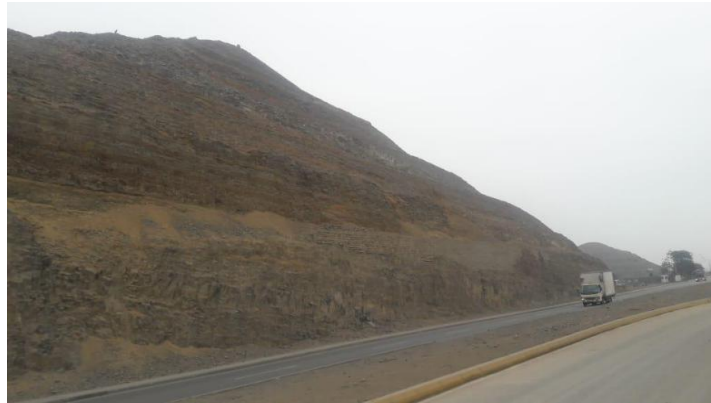
Figura 16. Toma frontal del terreno. (Fuente: Imagen propia, 2019)
