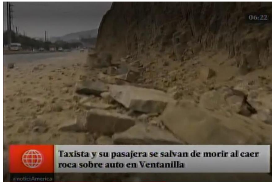
Figura 1. Av. Néstor Gambetta – La Pampilla, desprendimiento de rocas. (Fuente: América TV, 2016)
