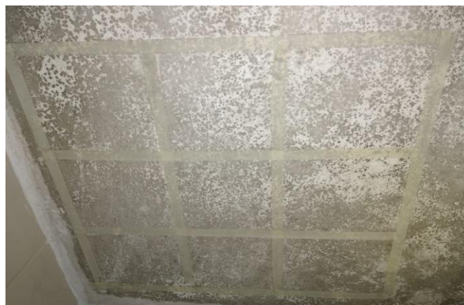
Figura 5. Divisiones de 9 cuadrantes en techo de concreto
