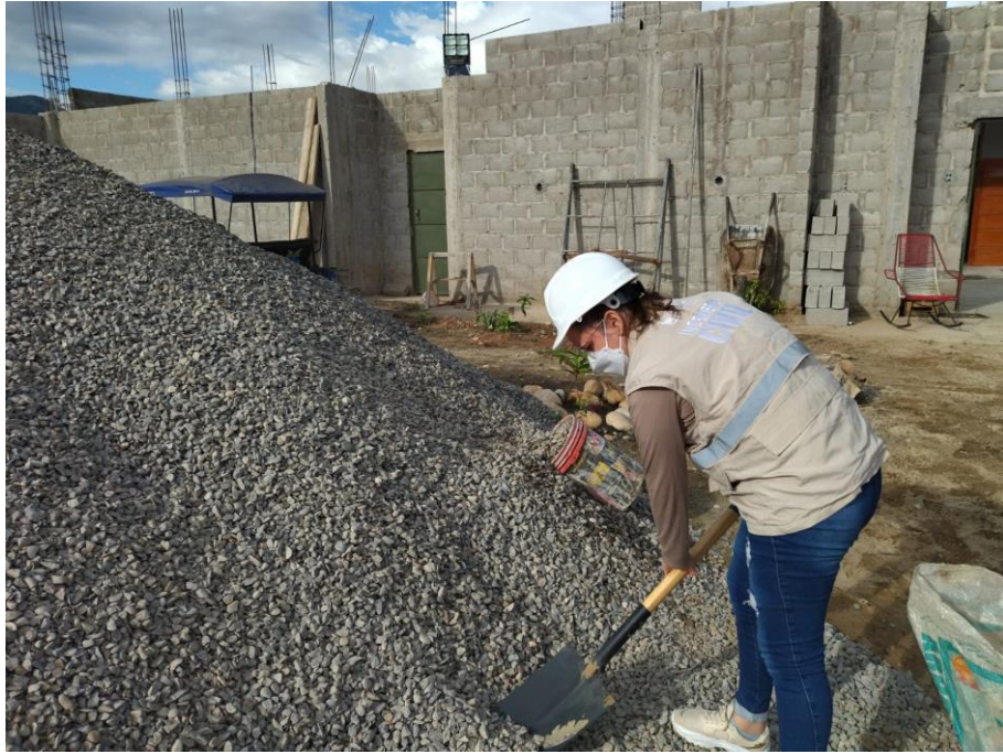
Foto N° 03: Extracción de material por parte de la autora.
