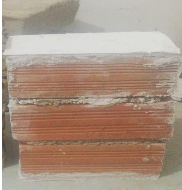
Figura 22: Pila de ladrillo pandereta sin refuerzo Fuente: Elaboración propio
