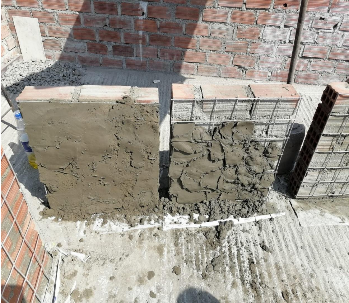
Figura 36: Tarrajeo de los muretes y pilas.
