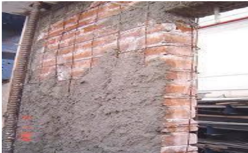
Figura 21: Tarrajeo respectivo de la malla con mortero 1:5
