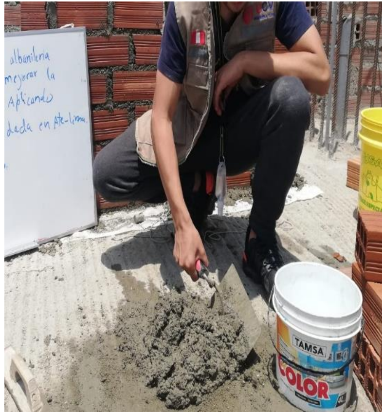
Figura 31: Preparación del mortero para el asentado del ladrillo pandereta.
