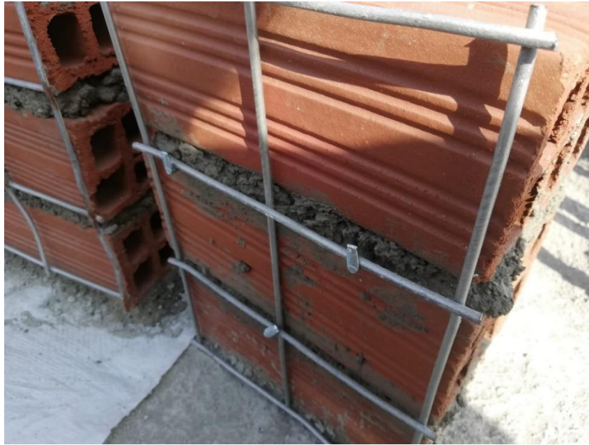
Figura 34: Anclaje de la malla electrosoldada en pilas.
