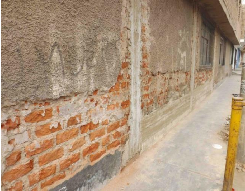
Figura 16: Limpieza respectiva de muro
