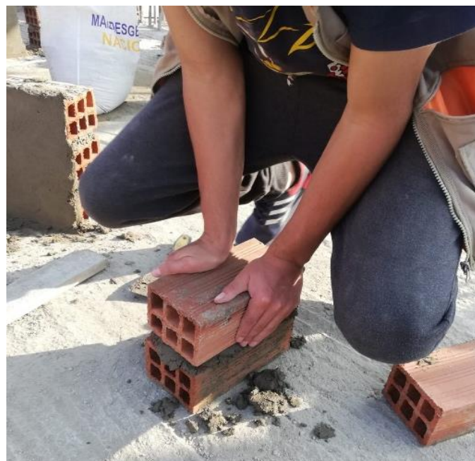
Figura 33: Asentado del ladrillo pandereta en pila
