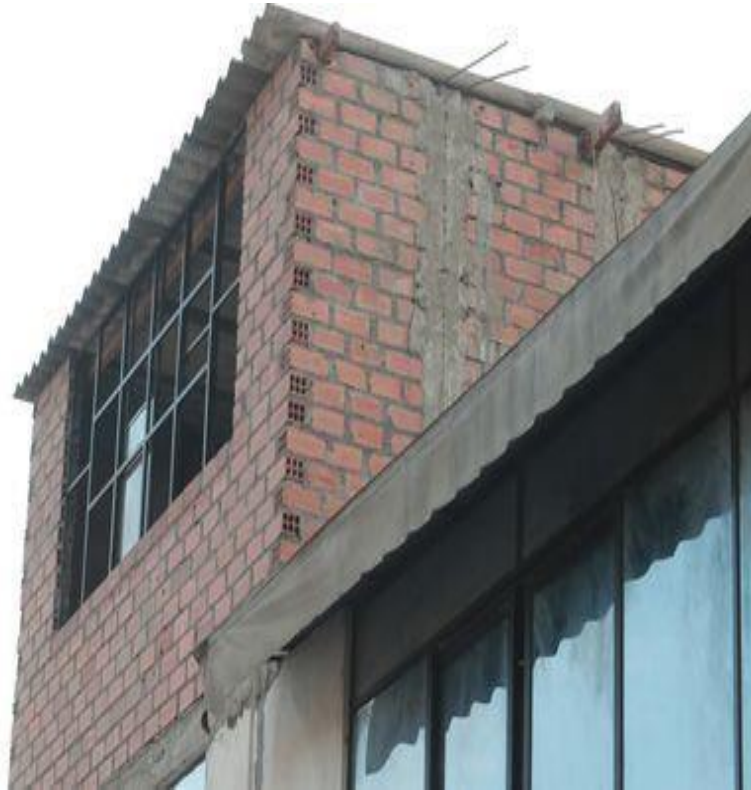
Figura 12: Vivienda construida con ladrillo pandereta.
