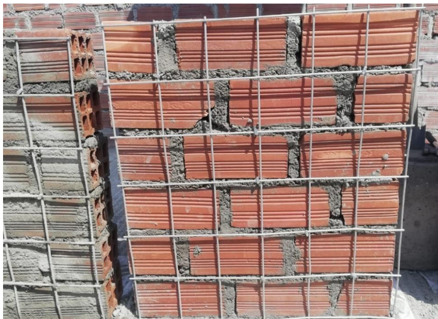
Figura 34: Anclaje de la malla electrosoldada en pilas.
