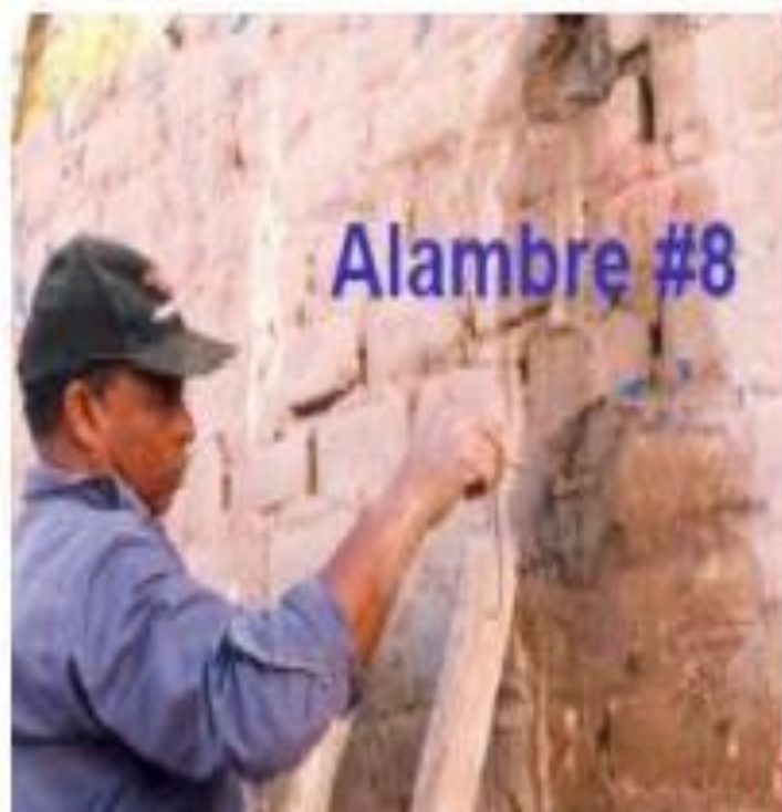
Figura 17: Instalación del conector de alambre y rellenado de la perforación
