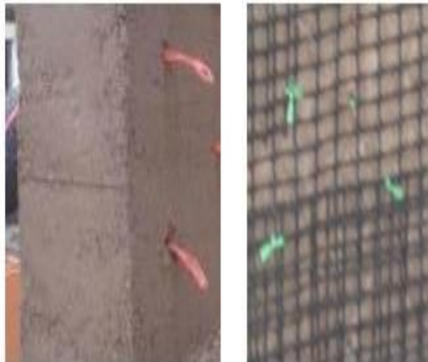
Figura 15: Conectores de paja rafia @25 cm
