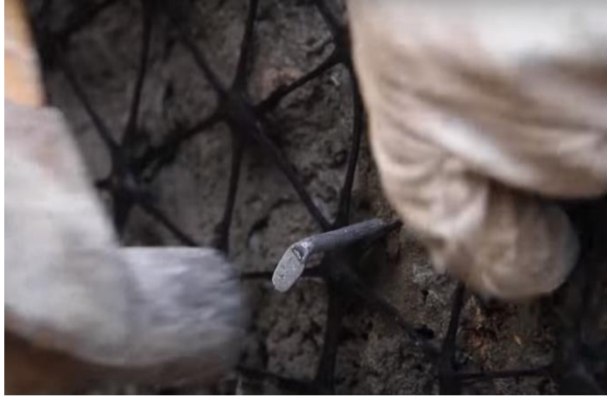
Figura 20: Fijación con alcayata la malla electrosoldada.
