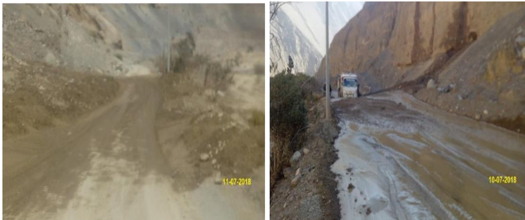
Figura: Panel Fotográfico - Km 739+400 Fuente: Elaboración propia.
