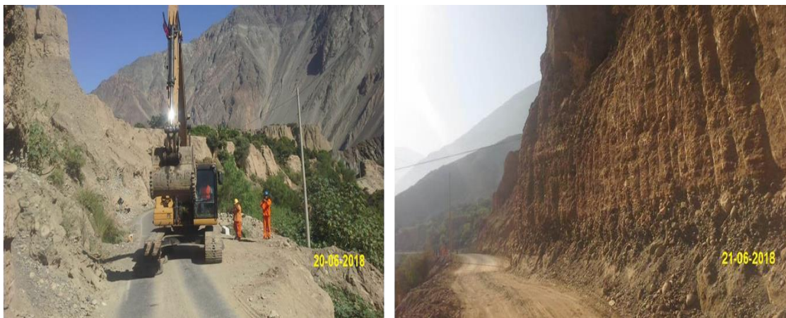
Figura: Panel Fotográfico - Km 735+340 Fuente: Elaboración propia.
