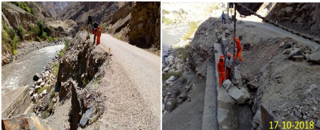
Figura: Panel Fotográfico - Km 721+150 Fuente: Elaboración propia.
