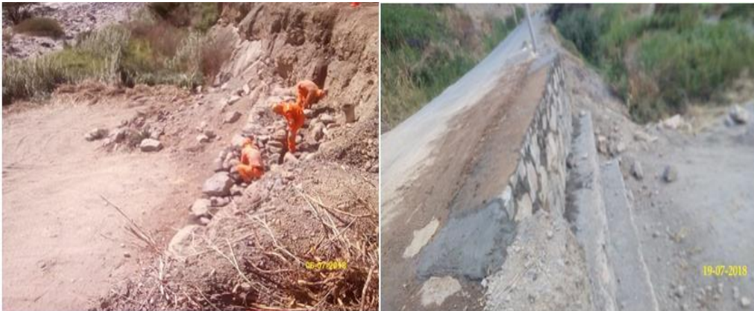
Figura: Panel Fotográfico - Km 740+200 Fuente: Elaboración propia.
