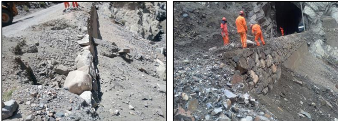
Figura: Panel Fotográfico - Km 115+300 Fuente: Elaboración propia.
