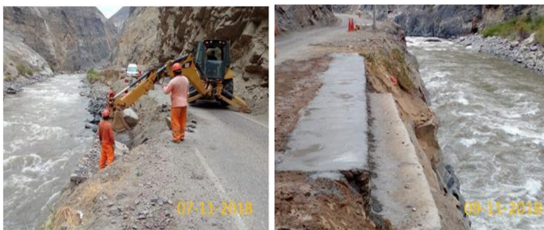
Figura: Panel Fotográfico - Km 717+200 Fuente: Elaboración propia.
