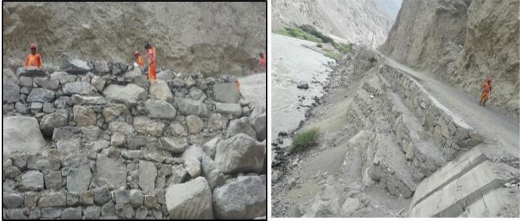
Figura: Panel Fotográfico - Km 748+360 Fuente: Elaboración propia.
