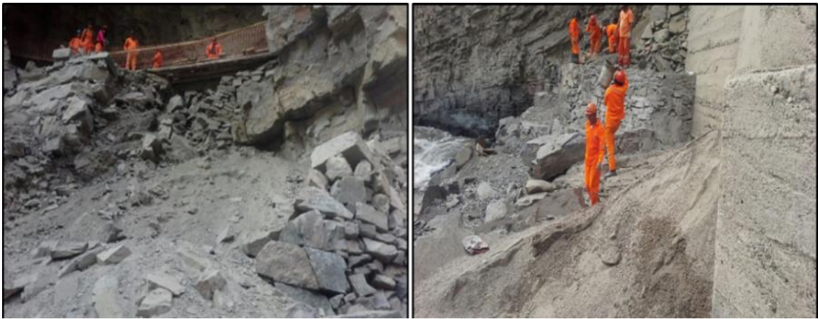
Figura: Panel Fotográfico - Km 718+810 Fuente: Elaboración propia.
