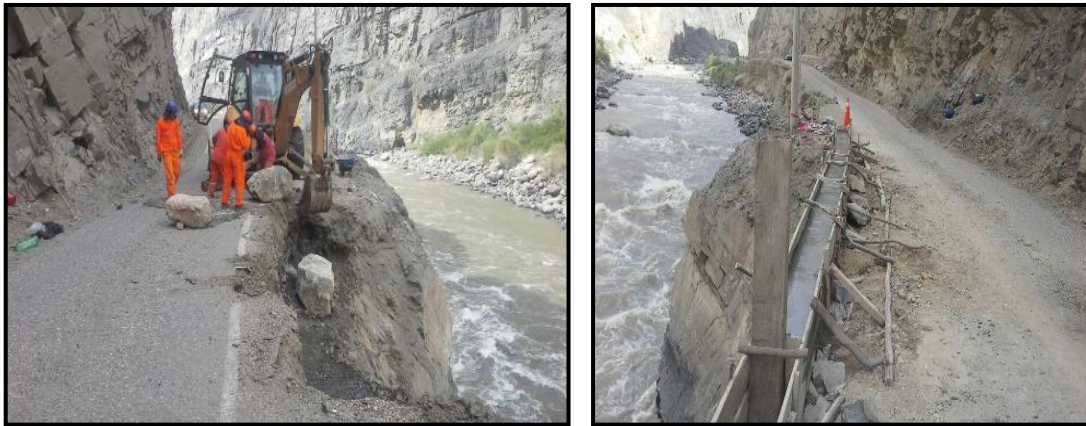
Figura: Panel Fotográfico - Km 717+270 Fuente: Elaboración propia.
