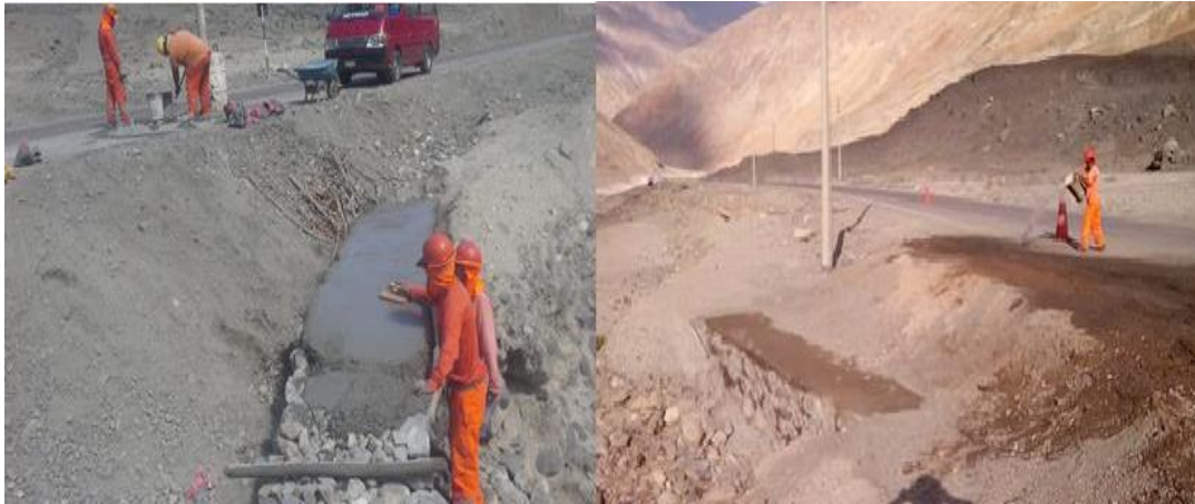
Figura: Panel Fotográfico - Km 751+500 Fuente: Elaboración propia.
