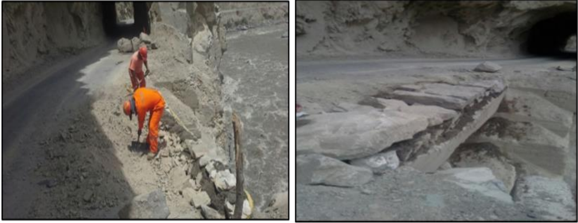
Figura: Panel Fotográfico - Km 747+200 Fuente: Elaboración propia.
