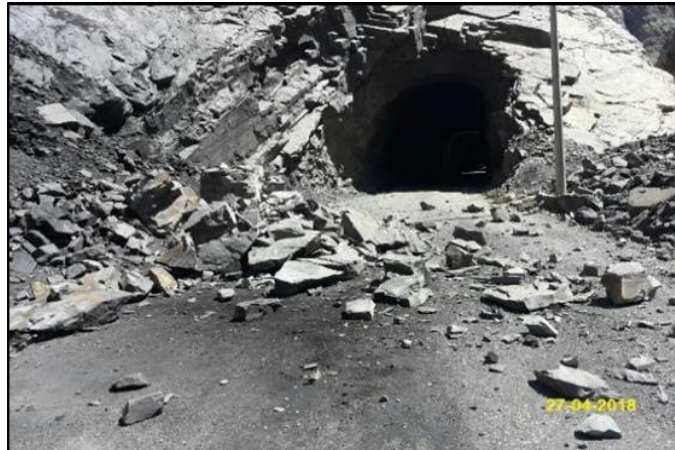
Figura: Panel Fotográfico - Km 715+700 Fuente: Elaboración propia.
