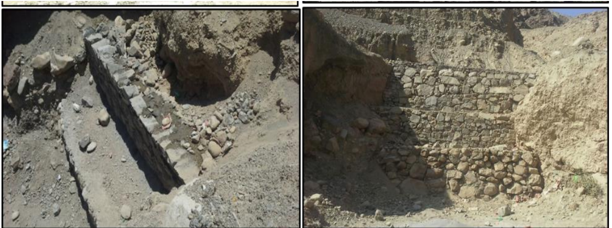
Figura: Panel Fotográfico - Km 727+030 Fuente: Elaboración propia.
