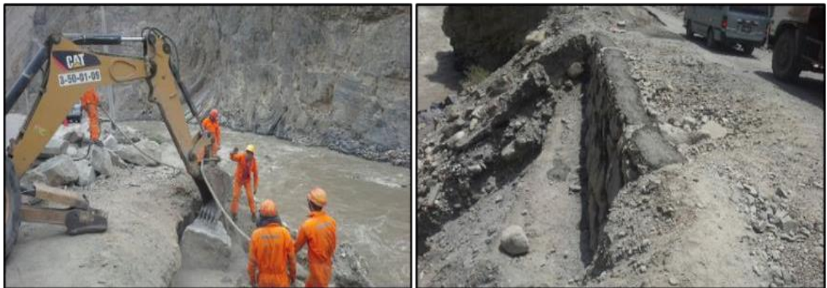
Figura: Panel Fotográfico - Km 726+030 Fuente: Elaboración propia.
