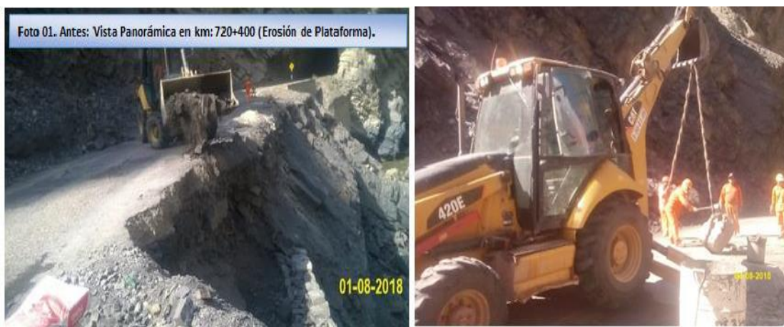
Figura: Panel Fotográfico - Km 720+400 Fuente: Elaboración propia.
