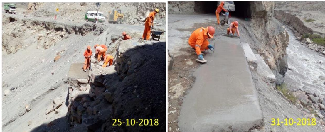
Figura: Panel Fotográfico - Km 724+780 Fuente: Elaboración propia.
