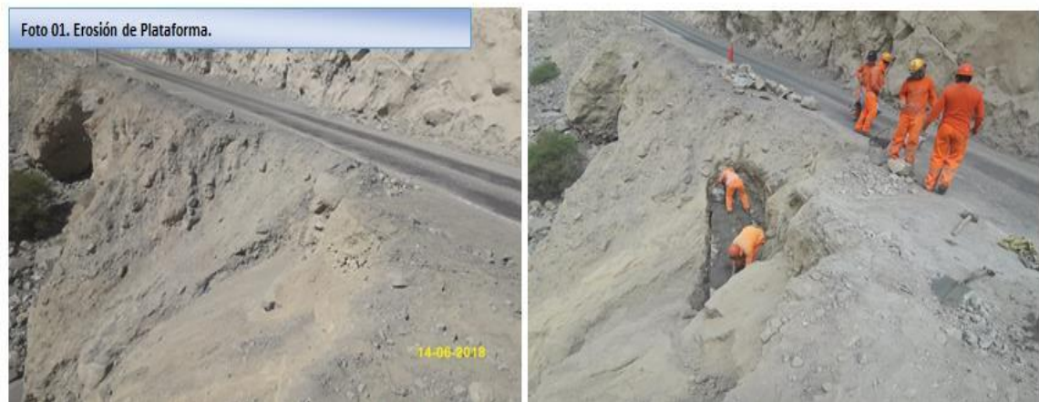
Figura: Panel Fotográfico - Km 748+500 Fuente: Elaboración propia.
