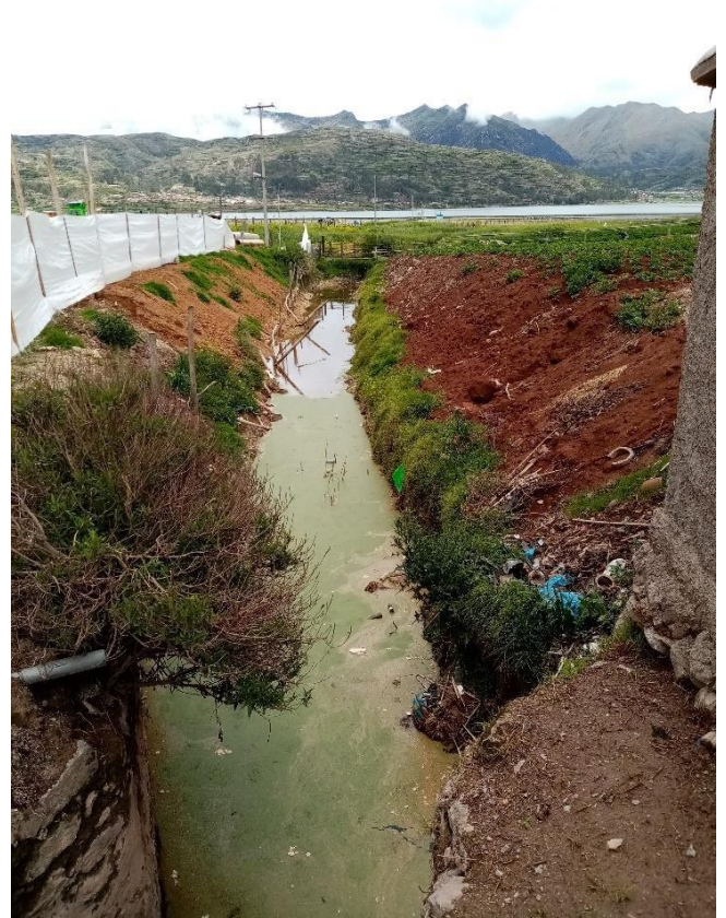
Foto N° 06: percepción de afluentes de agua a la laguna Piuray, en evidente estado de deterioro.
