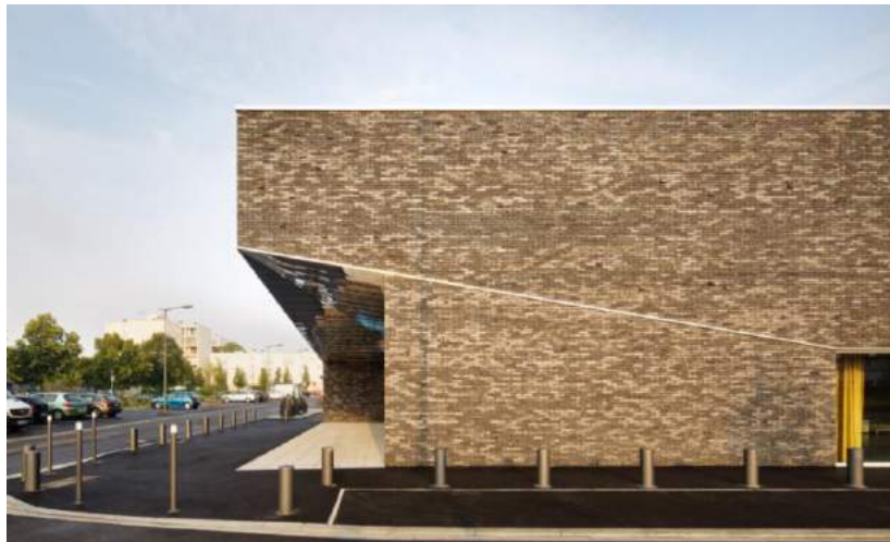
Figura 6: Foto de la fachada
