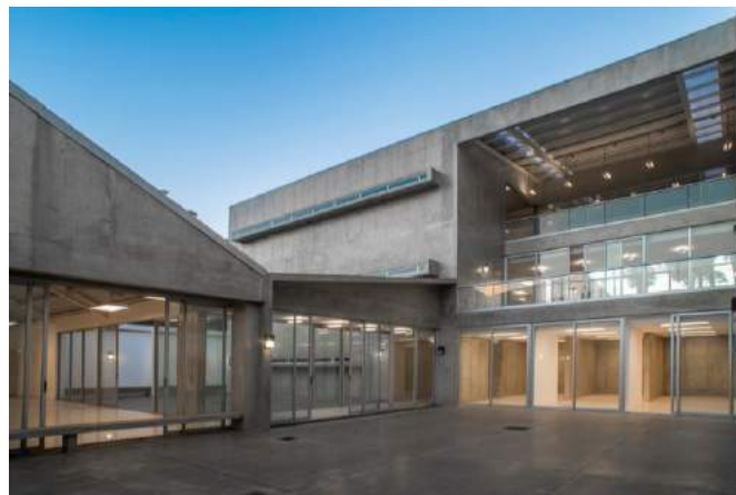
Figura 3: Hormigón expuesto
