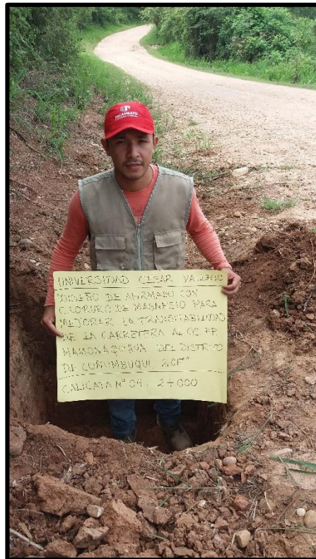
Imagen – 04: Extracción de muestra calicata N°04.
