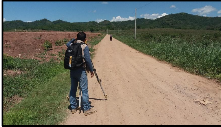
Imagen – 04: Se observa la toma de datos en el segundo tramo con la estación total.
