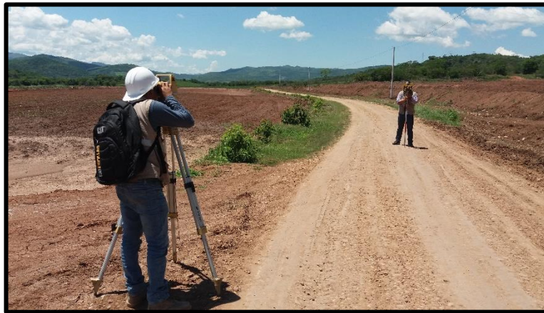
Imagen – 05: Se observa la toma de datos en el tercer tramo con la estación total.
