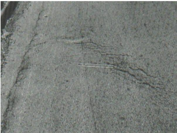
**Figura 58.** Grieta Parabólica Mediana Severidad.
