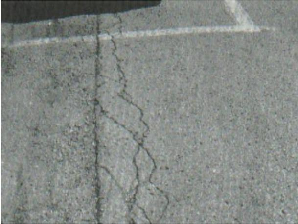
**Figura 29.** Grieta de Borde de Severidad Alta.
