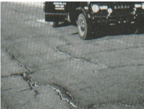
**Figura 15.** Grietas en Bloque de Alta Severidad.
