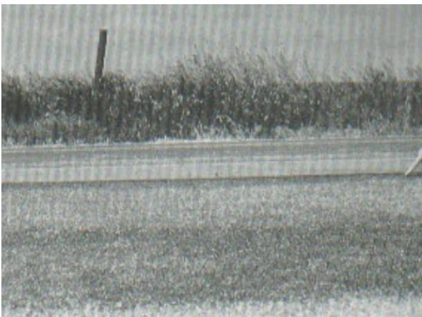
**Figura 21.** Corrugación de Baja Severidad.
