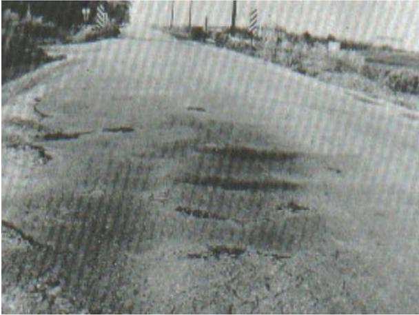
**Figura 55.** Desplazamiento de Severidad Media.
