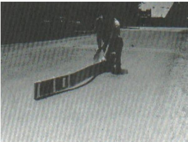
**Figura 54.** Desplazamiento de Baja Severidad.
