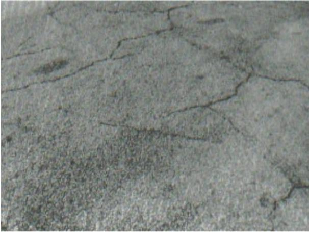
**Figura 13.** Grietas en Bloque de Baja Severidad
