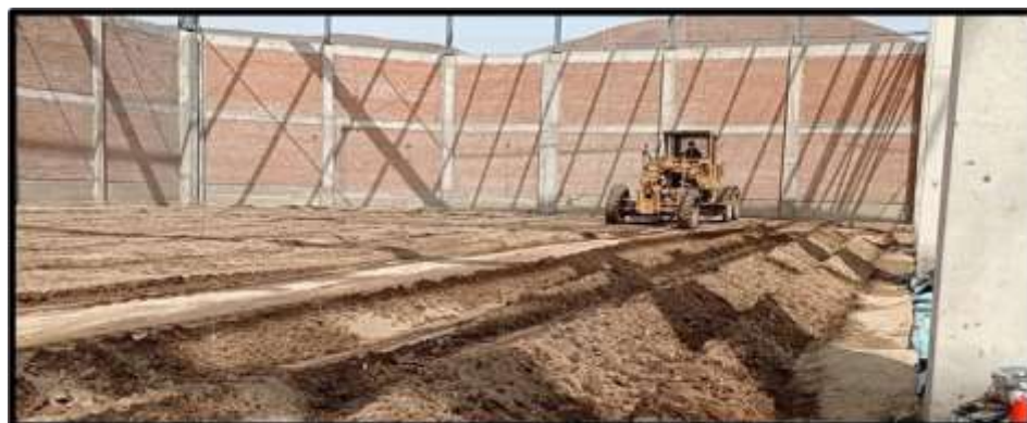
Figura 2 Escarificado de terreno natural.
