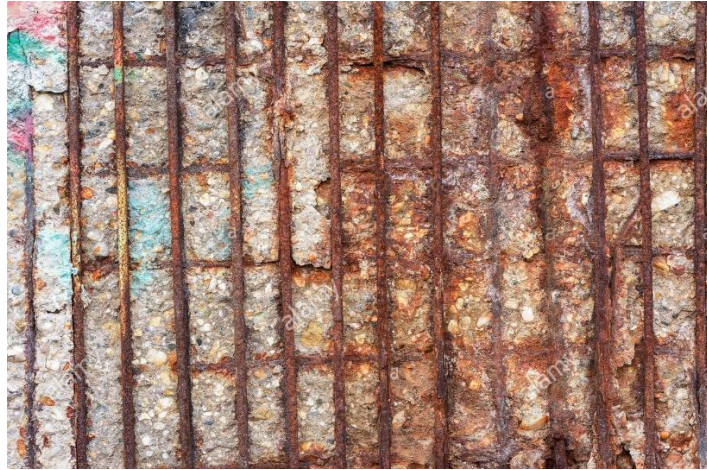
Figura 11. Corrosión.
