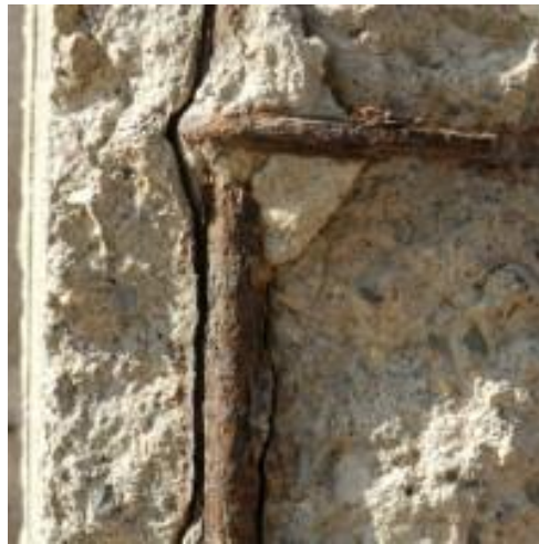
Figura 10. Oxidación
