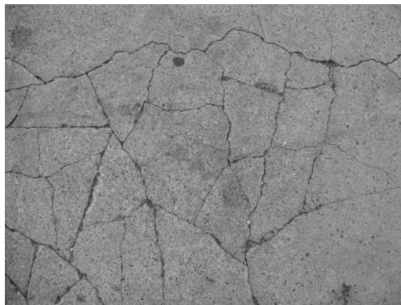
Figura 8. Fisuración.
