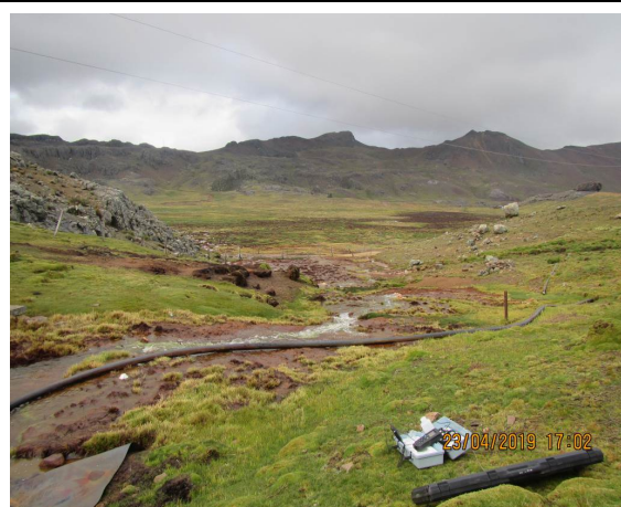
Tuberías y Efluentes – Zona Pampamachay
