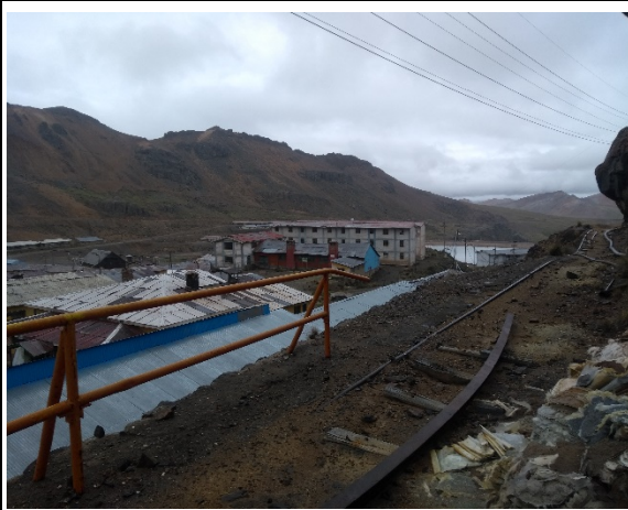
Vista General de Campamento, Almacenes y Oficinas.
