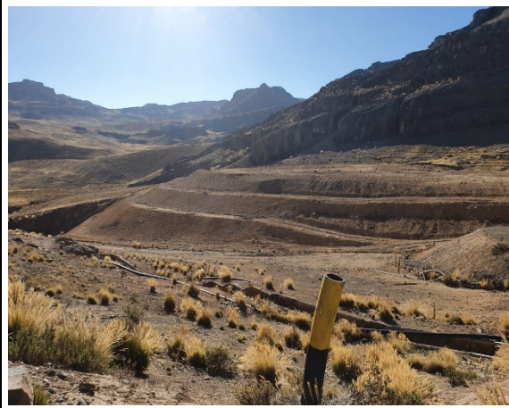
Depósito de Desmote sin revestimiento – Zona Beatricita.
