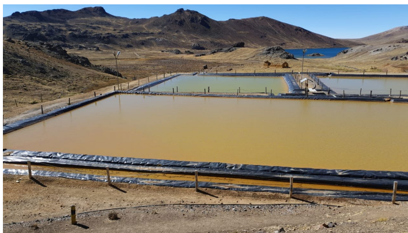
Planta de tratamiento de aguas ácidas – Zona Beatricita.
