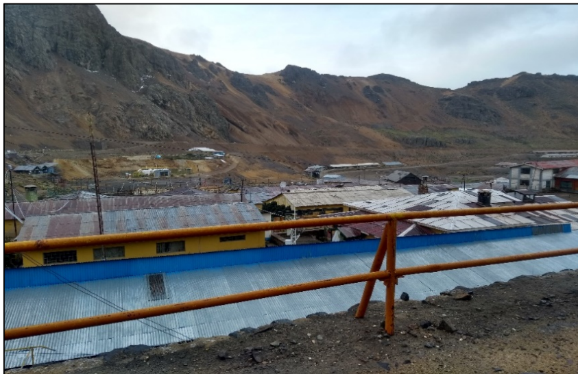
Figura 6. Campamento, Talleres y Almacenes San Genaro (abandonados)
