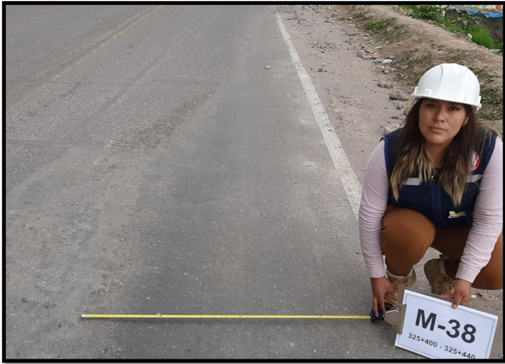
FOTO N°05: Tipo de Falla tipo Exudación en la via Libertadores.
