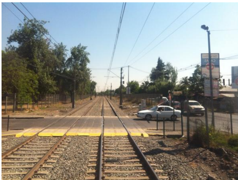
Figura N° 22: Falla tipo cruce vía férrea
