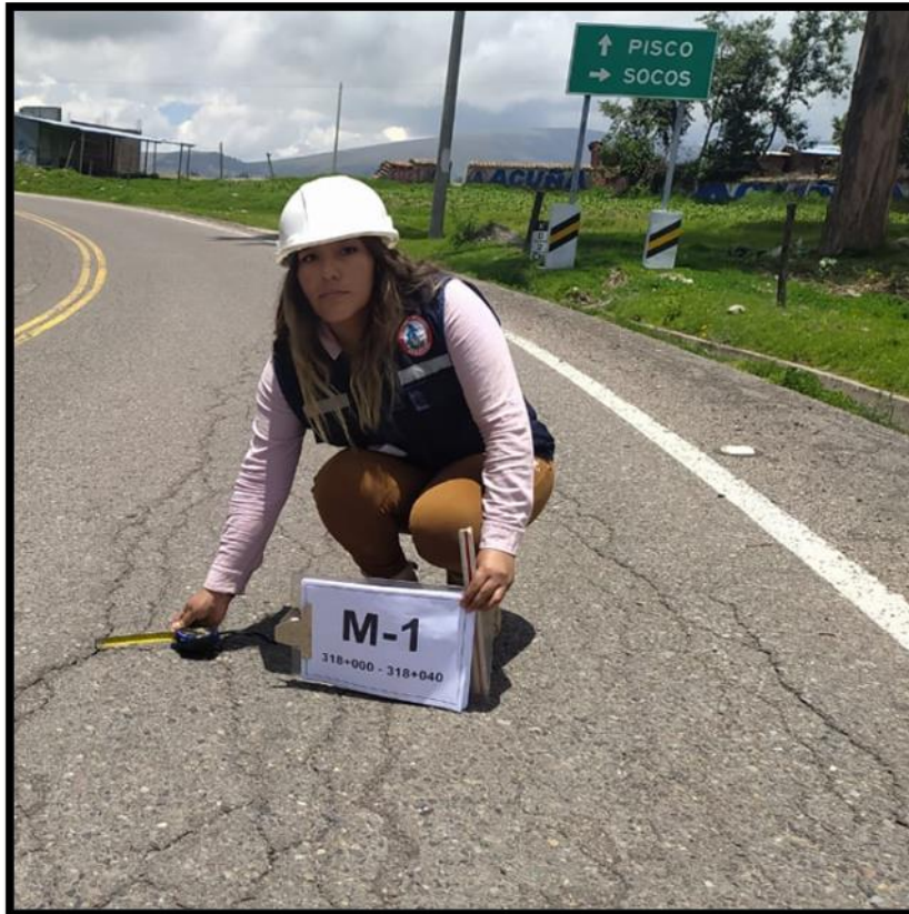
FOTO N°01: inicio de tramo km 318+000, reparticion de Socos
