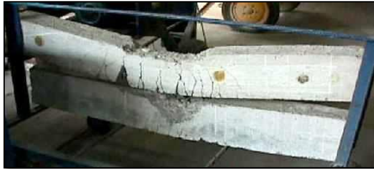
Figura. 07. Falla por Aplastamiento en vigas
