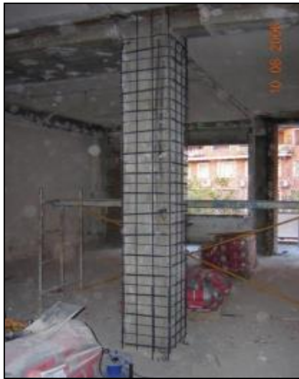
Figura. 09. Columna en el proceso de encamisado
