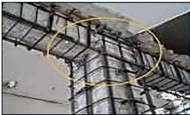
Figura. 10. Encamisado de caras de viga
