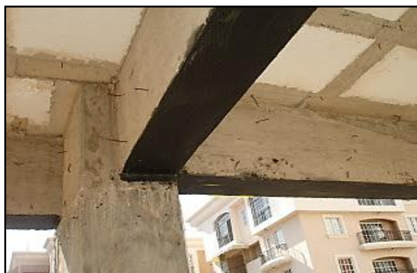
Figura. 11. Refuerzo De Vigas Con Fibra De Carbono
