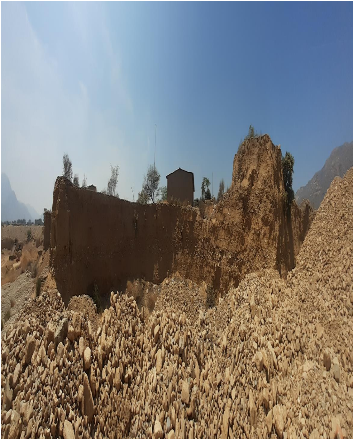
Figura 16. Viviendas cercanas al Talud.
