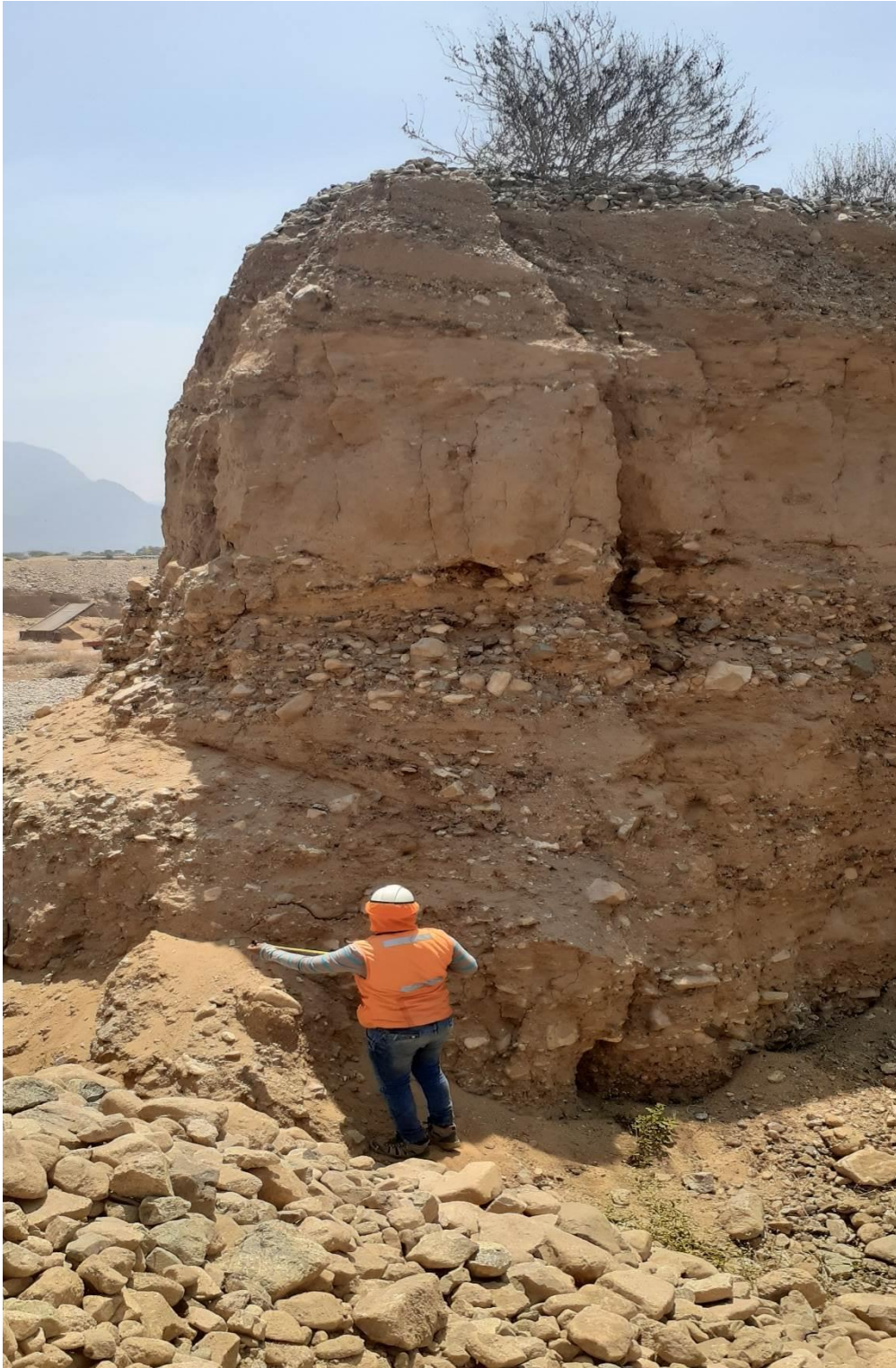
Figura 19. Estudio del Talud.
