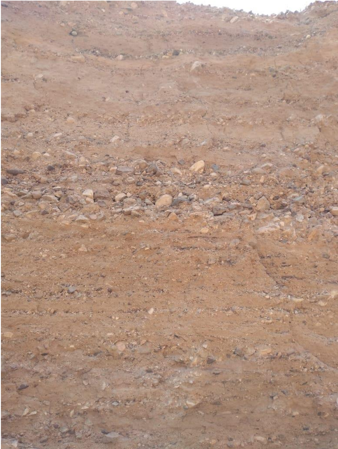
Figura 14. Estratigrafía del Talud.
