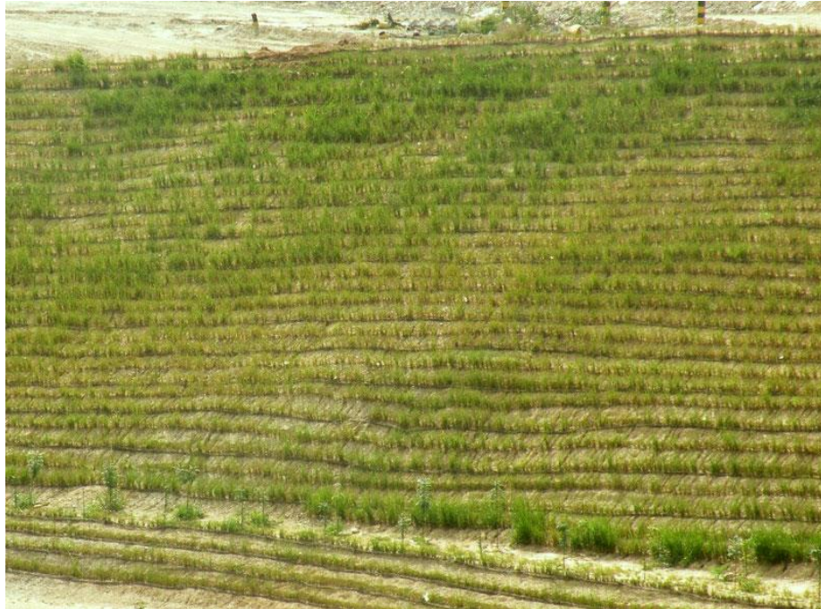
Figura 11. Siembra de talud.
