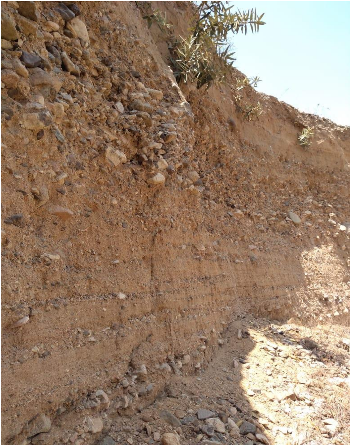
Figura 15. Estratigrafía del Talud.
