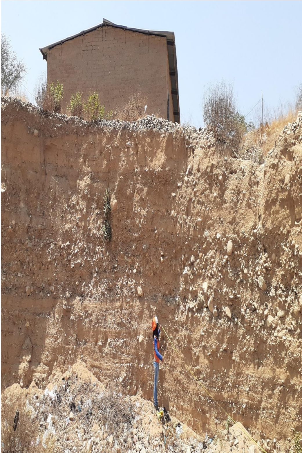
Figura 22. Estratigrafía del Talud 2.
