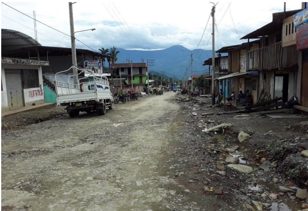
FIGURA 9: vista fotográfica (prog. 0+560), las condiciones deficientes para una adecuada transitabilidad peatonal, además la inexistencia de veredas para el tránsito seguro de peatones
