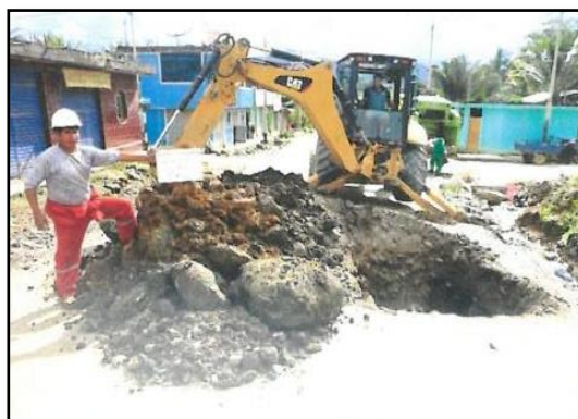
Figura 46.- Se observa el material extraído de la calicata C-05.
