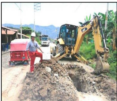
Figura 45.- Se observa el material extraído de la calicata C-03.
