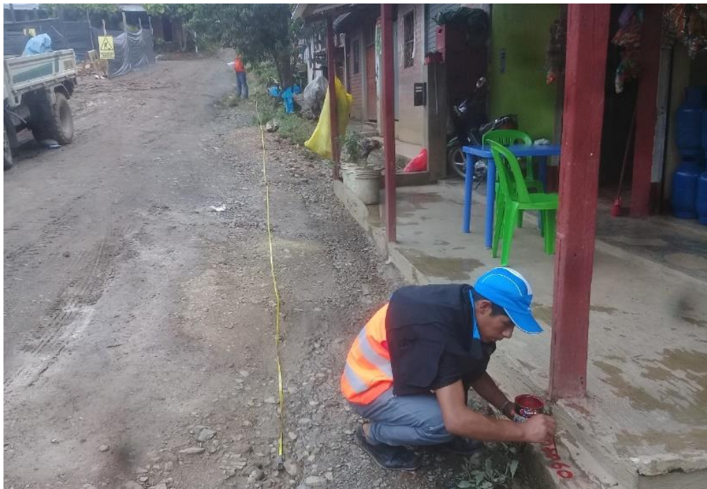
FIGURA 7: WINCHEO Y PINTADO DE PROGRESIVAS EN LA AV. PRINCIPAL EN INGRESO KIMBIRI ALTO
