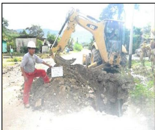
Figura 47.- Se observa el material extraído de la calicata C-06.
