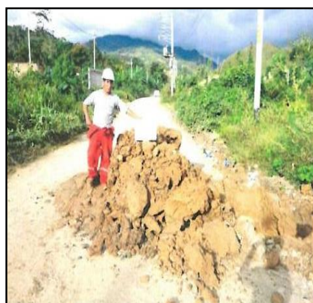
Figura 48 .- Se observa el material extraído de la calicata C-07.
