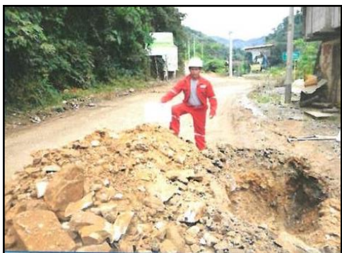
Figura 43.- Se observa el material extraído de la calicata C-01
