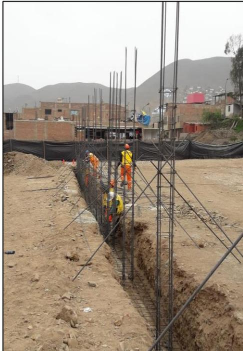
*Figura 15:* Colocación de columnas cada 3m.
