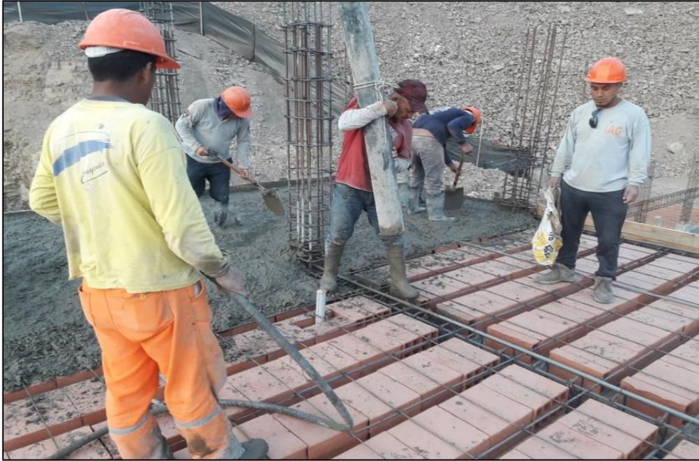
*Figura 22: Vaciado De La Losa De La Caseta De Serenazgo*
