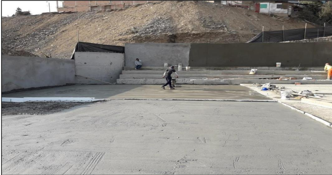
*Figura 23: Uso De La Alisadora Helicóptero Para La Losa Deportiva*
