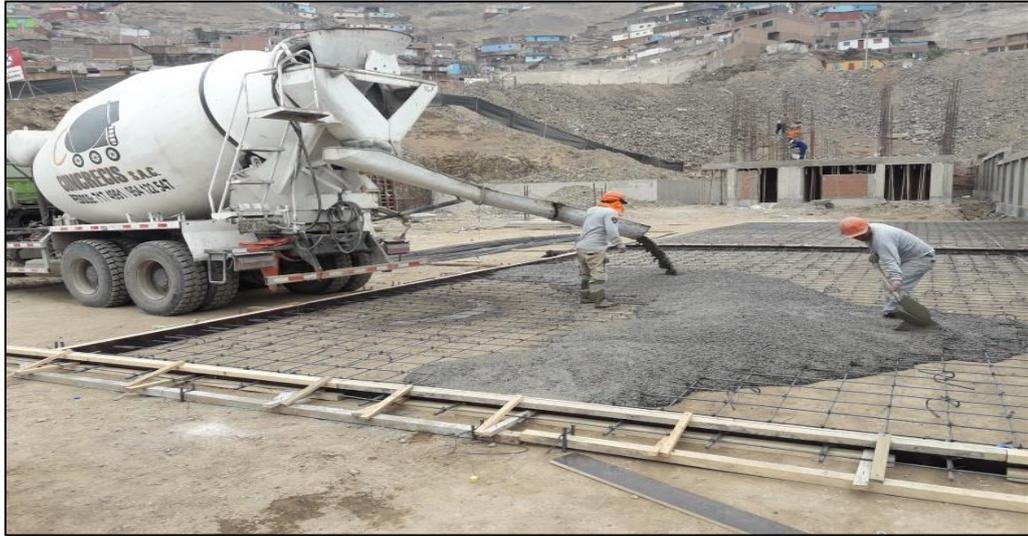
*Figura 20: Vaciado de Losa Deportiva 1*
