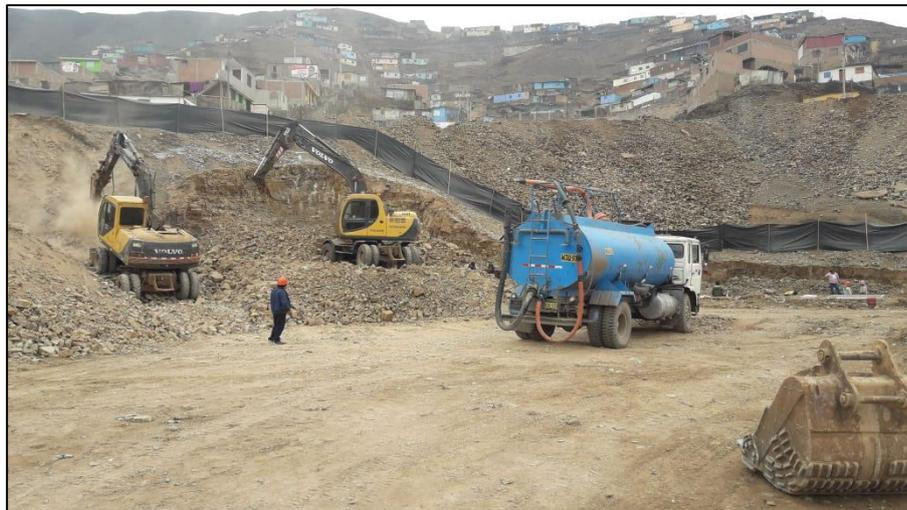
*Figura 11: Excavación Masiva con Equipo 2*
