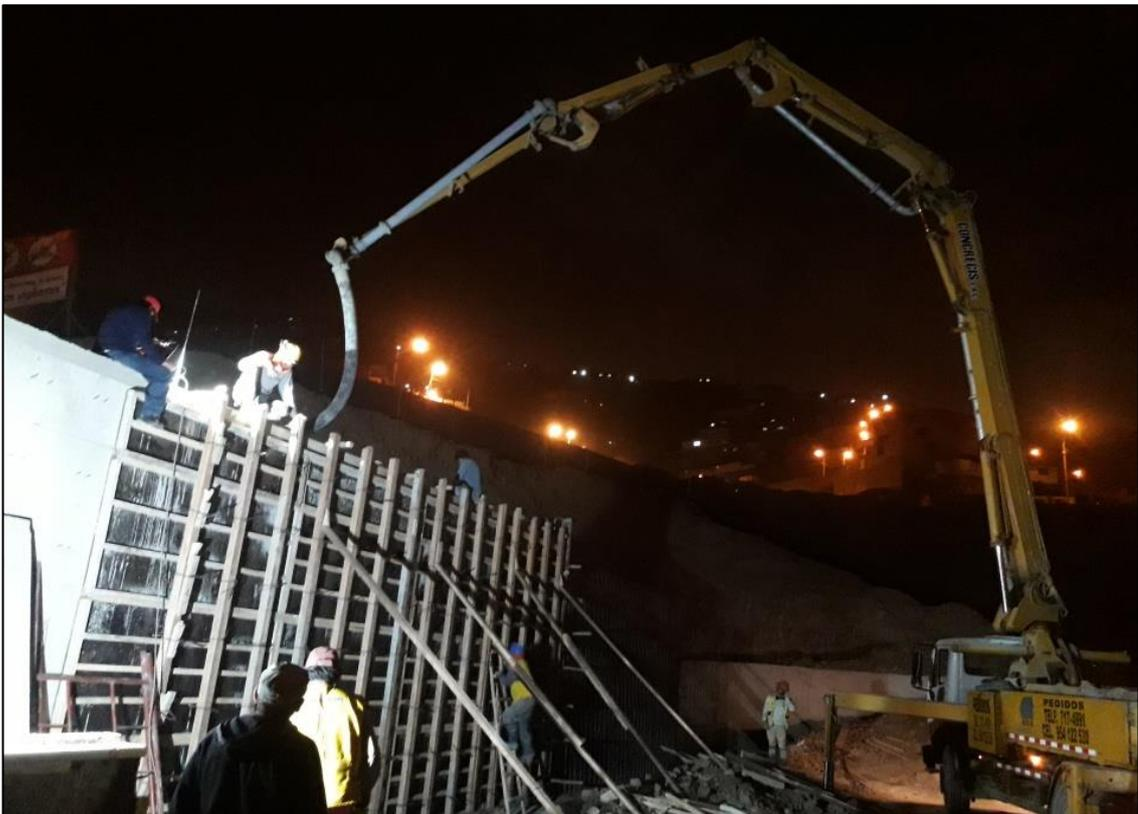
*Figura 17: Vaciado de Placa perpendicular a la Gradería*
