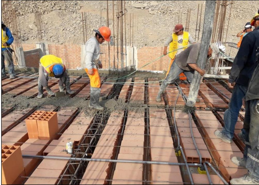
*Figura 18:* Vaciado de Losa del Vestuario
