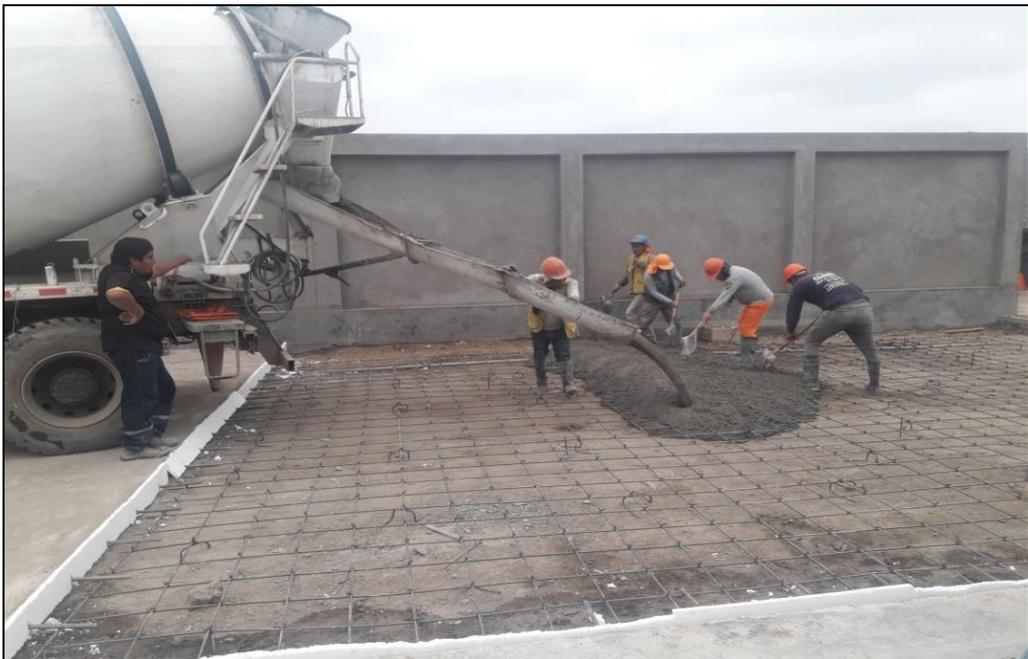
*Figura 21: Vaciado de Losa Deportiva 2*
