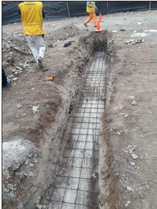
*Figura 14:* Colocación de mallas para la zapata.
