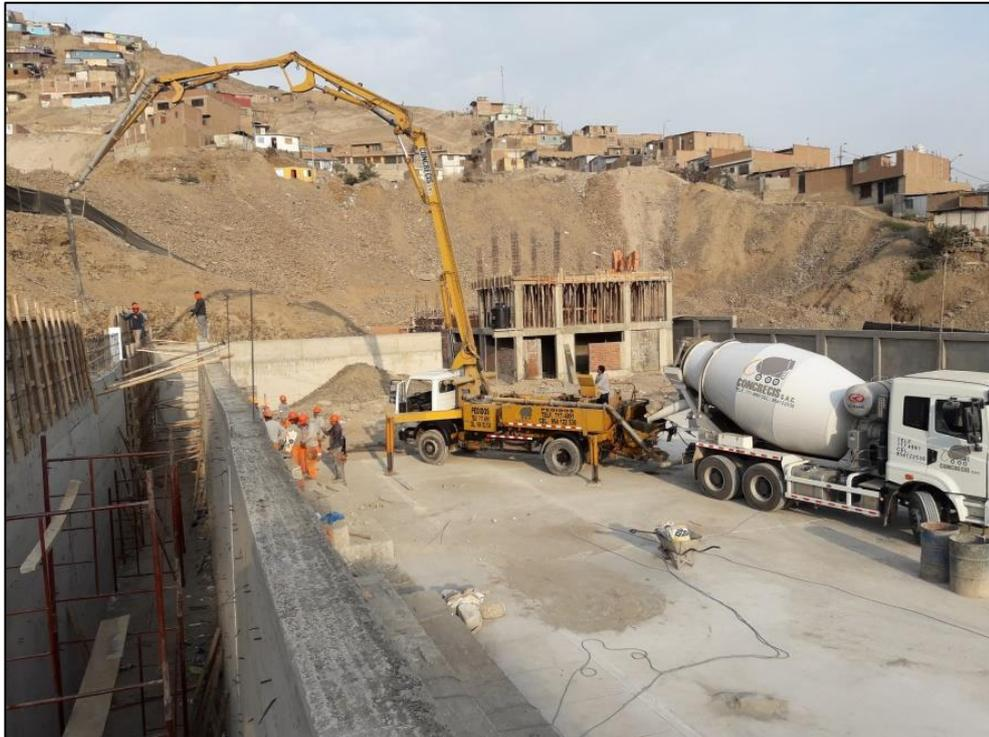
*Figura 25: Vaciado De Placa*
