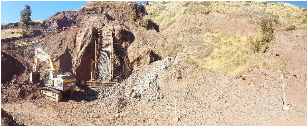
Figura 11. Vista panorámica de la cantera.
