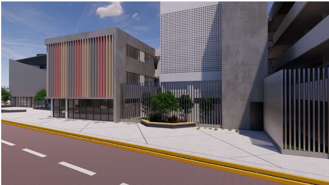
Figura 75. Fachada de biblioteca, servicios higiénicos y escalera de evacuación. Fuente: Elaboración propia
