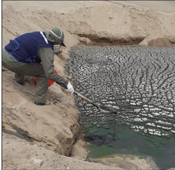
*Fotografía 1: Extracción de lodos de aguas residuales de la PTAR San Pedro de Ancón*
