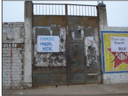
Fotografía N° 09 Portón de ingreso al terreno
