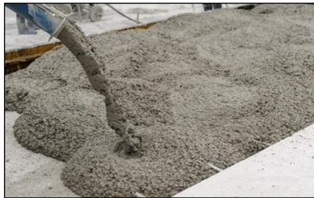
Figura 5. Muestra de Concreto en su etapa de vaciado
