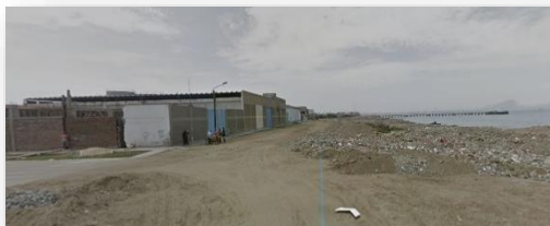
Imagen N° 16: Vista calle Jr. Junín Fuente: Google Maps
