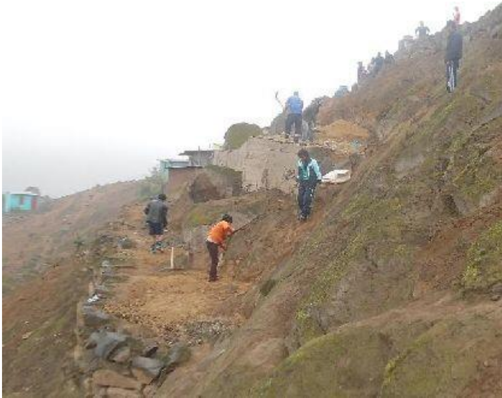
Fotografía 1. Durante los trabajos de habilitación de los andenes
