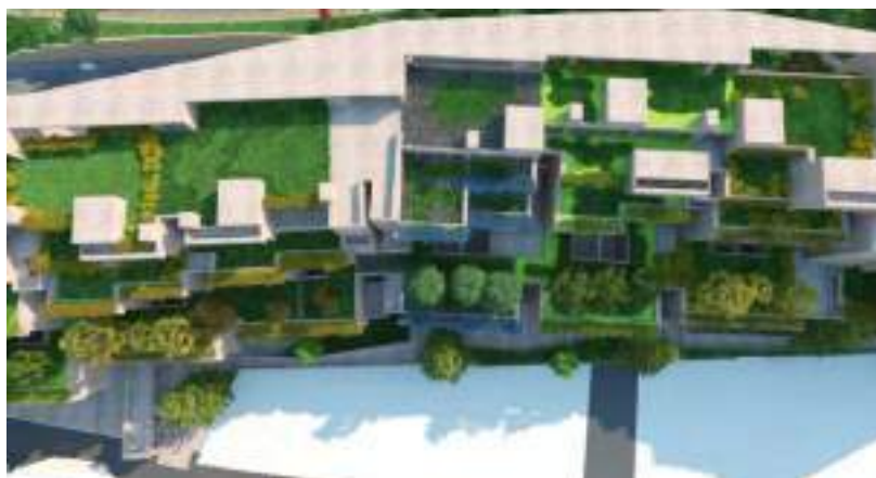
Figura 20. Vista aérea de la Universidad de Ingeniería y Tecnología
