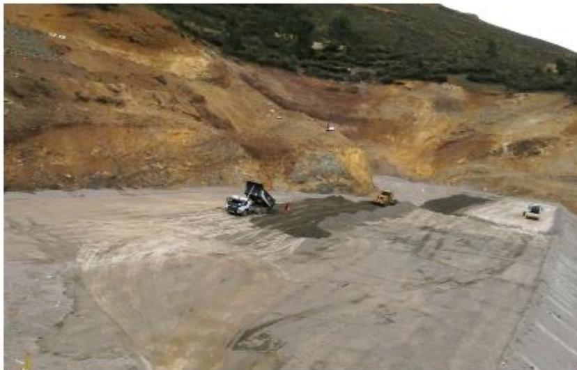
**Foto 1:** Conformación y compactación de la cota 3570.35 msnm
