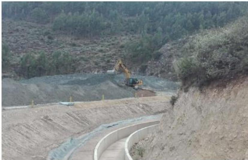
**Foto 6:** Encofrado de la rápida y el dissipador Prog.: 0+737.20 - 0+750.
