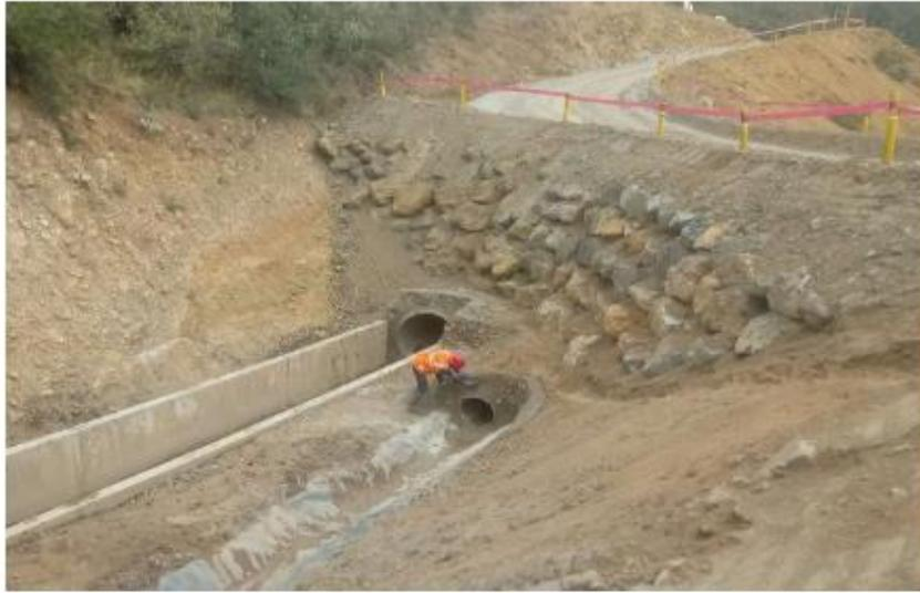
**Foto 7:** Limpieza y emboquillado de la alcantarilla en el nuevo acceso que se habilitó del RF1 – R10.
