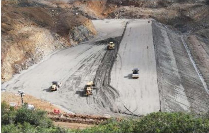
**Foto 15:** Conformación y compactación de la cota 3570.70 msnm
