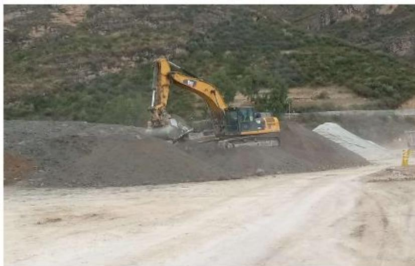
**Foto 2:** Preparación de mezcla en la plataforma RF1.
