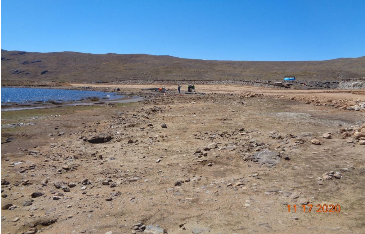
Figura 41. En vista se observa el proceso constructivo de material de cantera (grava limosa con arena), son compactados grava y material de aguas arriba de la presa.
