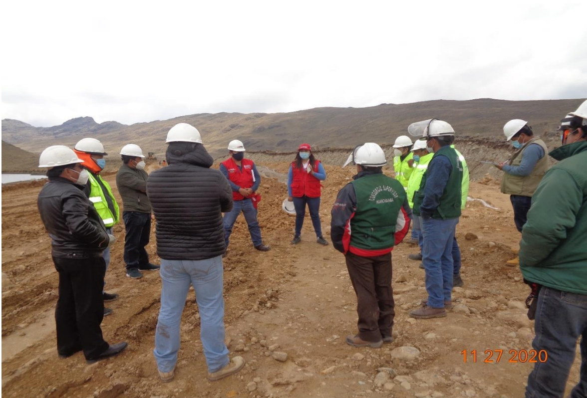
Figura 46. En vista se observa la visita del MINISTERIO DE VIVIENDA, CONSTRUCCIÓN Y SANEAMIENTO sobre las dudas de filtraciones y proceso de cimentación del dique.
