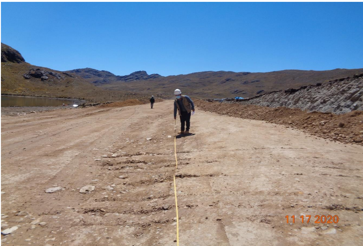
Figura 42. En vista se observa la verificación de la longitud de la corona y la compactación del dique.
