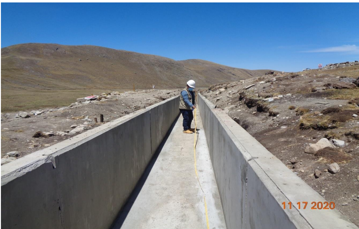
Figura 54. En vista se observa la verificación y recomendaciones al contratista sobre los trabajos finales del aliviadero, observando sobre las juntas del aliviadero.
