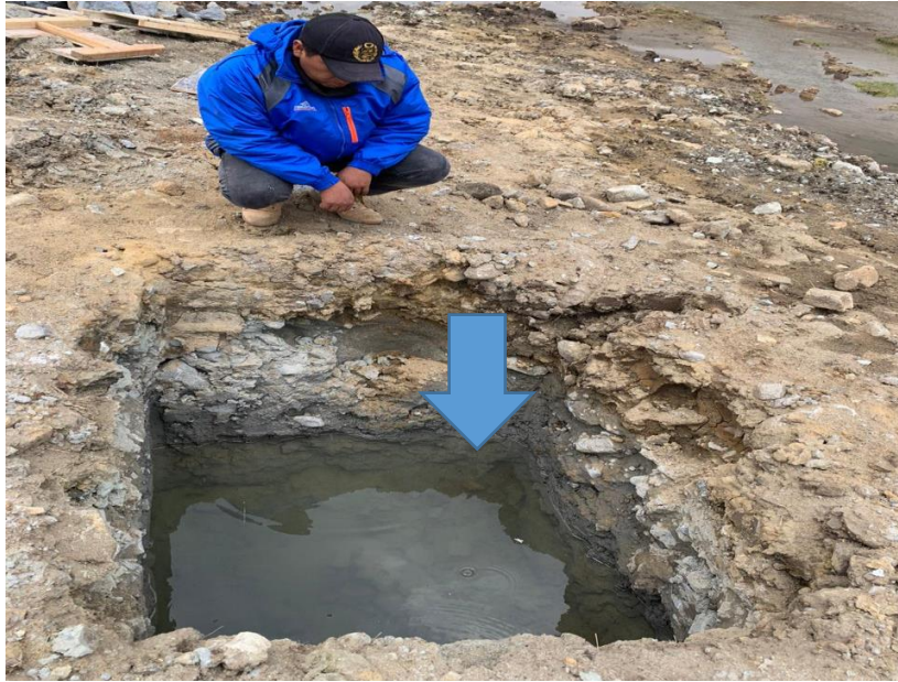
Figura 10. Vista de una excavación en la zona de la cerrada
