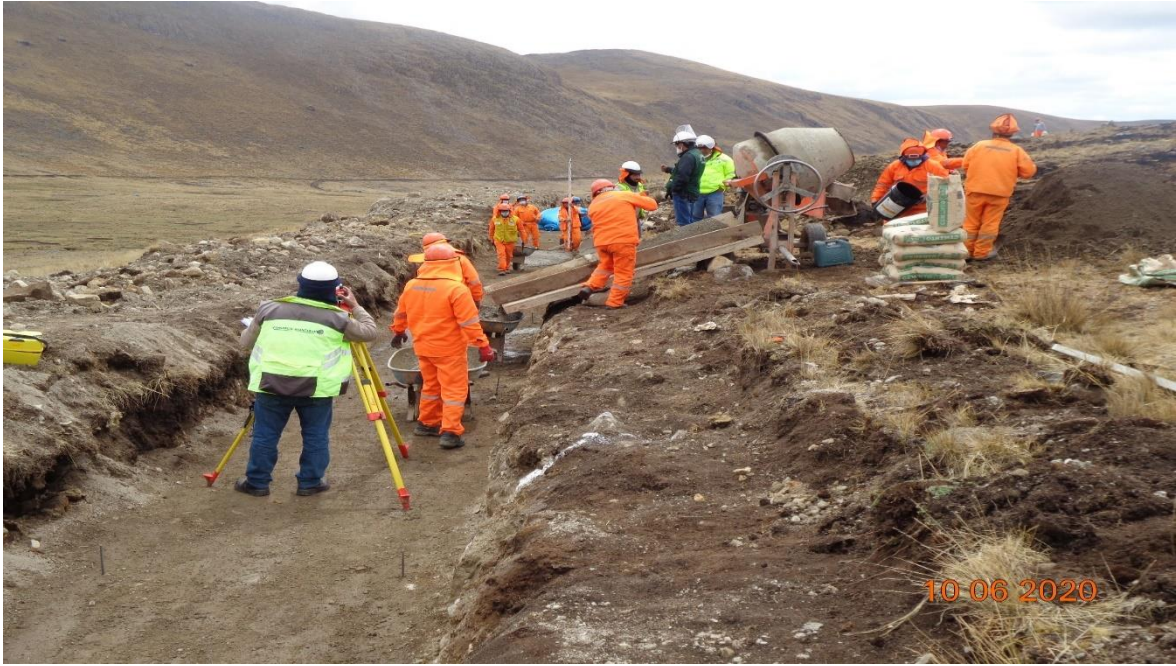
Figura 49. En vista se observa los trabajos de inicio y reubicación del aliviadero de la presa de captación.
