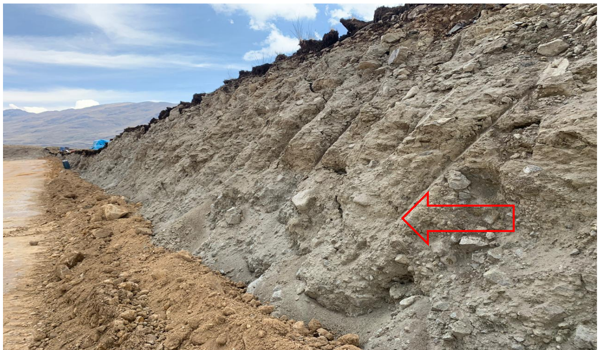
Figura 8. Vista de la estratificación
