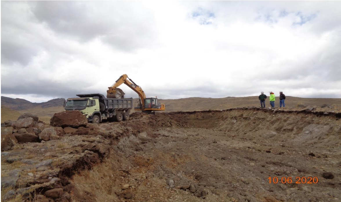
Figura 43. En vista se observa los trabajos del proceso del corte y cimentación del dique de la presa.
