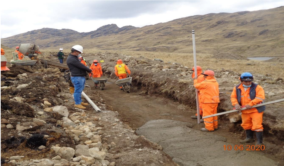
Figura 51. En vista se observa la verificación del proceso constructivo del aliviadero y replanteo del parte del topógrafo del contratista según lo especificado en el expediente técnico.
