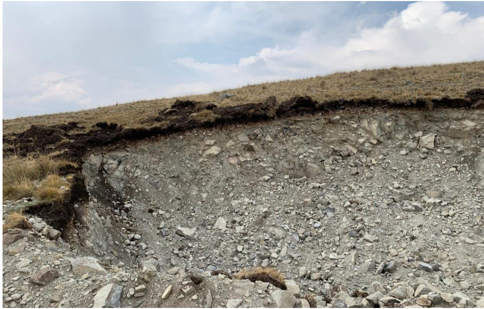
Figura 20. Cantera explotada para el relleno del dique
