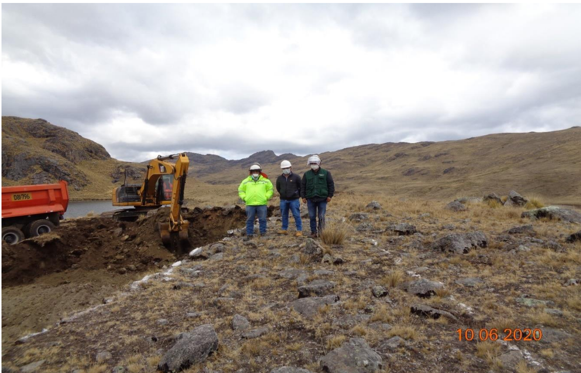
Figura 44. En vista de observa el proceso de supervisión de los trabajos de excavación y monitoreo de los trabajos del corte.
