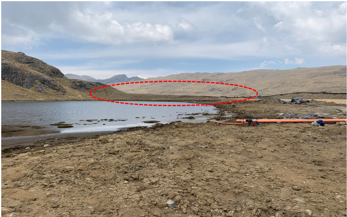
Figura 32. En vista se observa el terraplén natural de morrenos que definitivamente será una zona filtración importante al levantar la carga hidráulica de la laguna.
