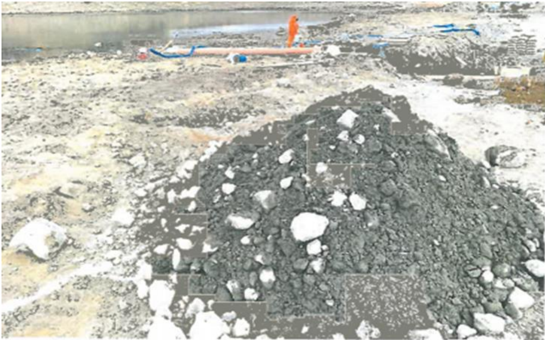
Figura 12. Conformación del terreno excavado
