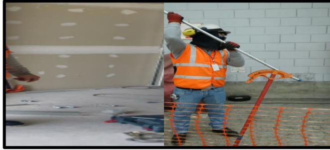
Figura 15. Doblado de tubería 3/4" a 90°
