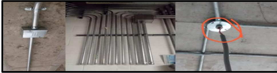
Figura 17. Instalación de cajas octagonales, cajas de 100x100x0.50 en techo
