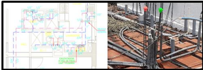
Figura 7: Instalaciones sanitarias.
