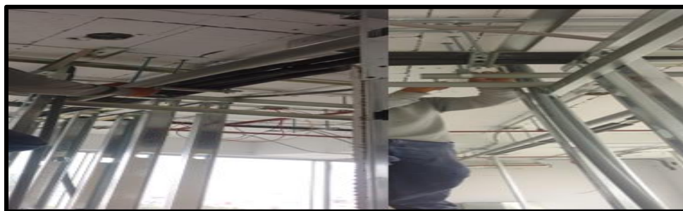
Figura 14. Colocado de varilla roscada, tuberías a una altura de 4 mts.
