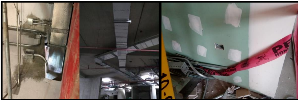
Figura 13. Apilamiento de tuberías y bandejas ranuradas.
