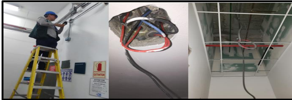
Figura 20. Empalmado de conductores /Conduit
