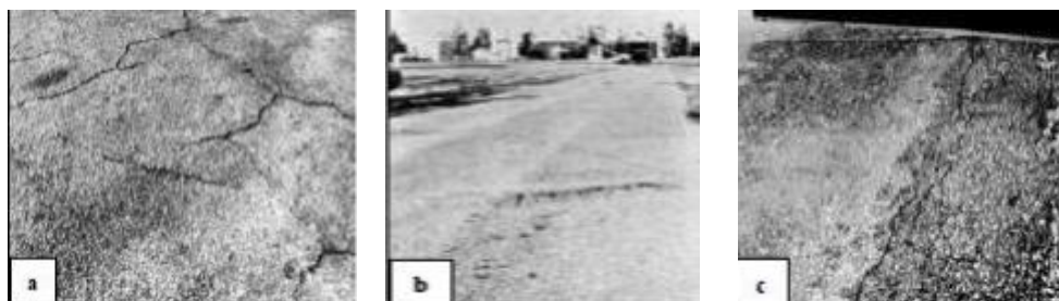
Figura 11: Abultamientos de niveles de gravedad bajo (a), medio (b) y alto (c).
