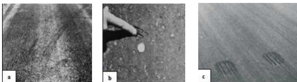
Figura 9: Exudación de nivel de gravedad bajo (a), medio (b) y alto (c).
