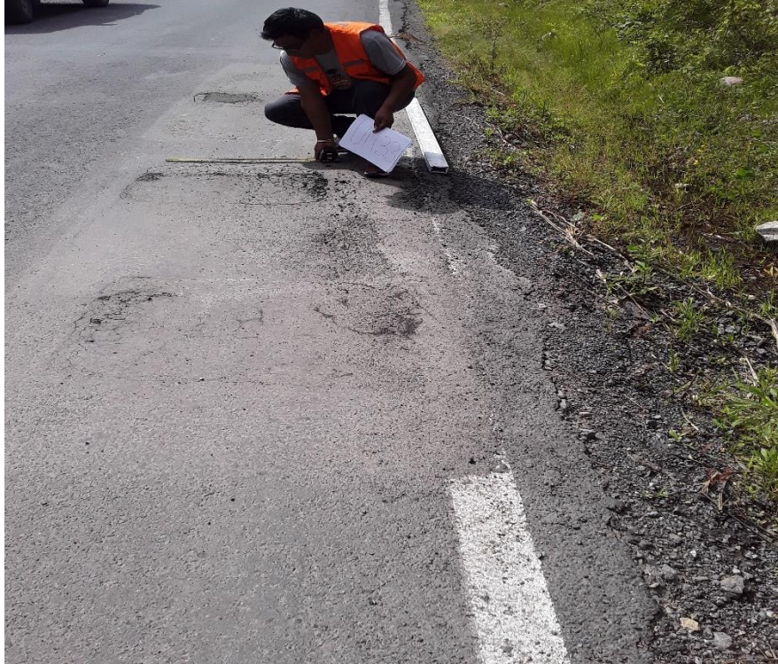
se ubica falla de tipo piel de cocodrilo en parches con severidad alto
