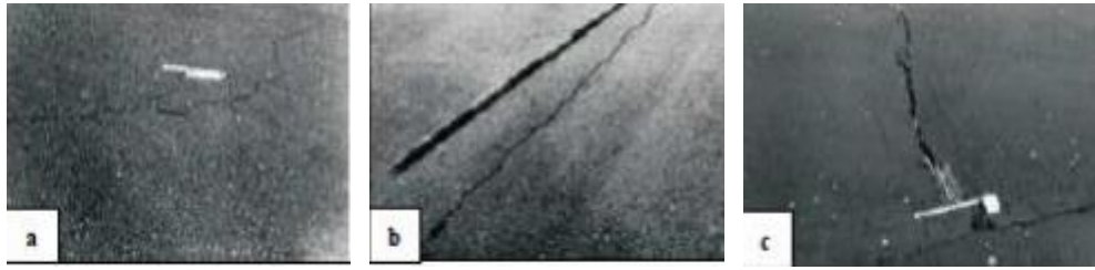
Figura 16: Fisuras de niveles de gravedad bajo (a), medio (b) y alto (c).
