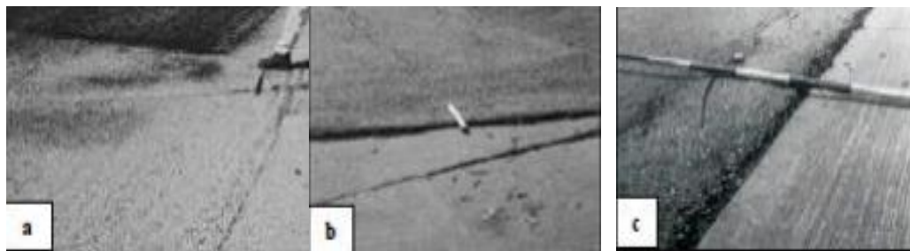
Figura 20: Desplazamiento de nivel de gravedad bajo (a), medio (b) y alto (c).
