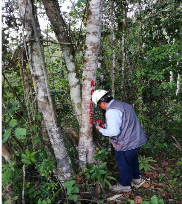
Fotografía 11. Aprecia la anotación de las progresivas proyectado de la Línea de conducción.
