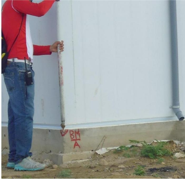
Fotografía 13. Se observa el punto de control BMA, se ubicó en Esquina de vereda de concreto, Señalizado con pintura roja.
