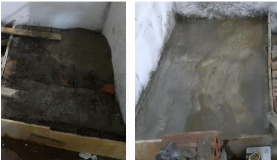
Figura N° 11 Colocado de concreto en especímenes tipo losa aligerada
