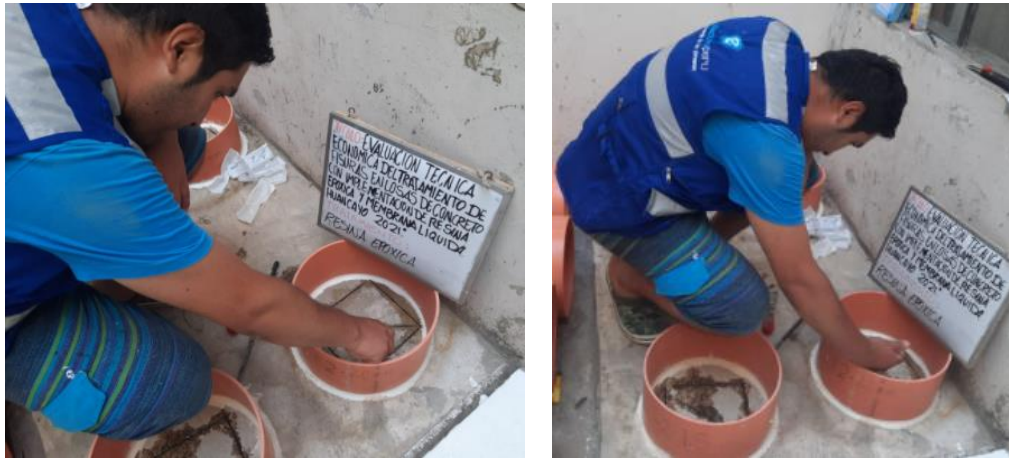
Figura Nº 34 Aplicación con resina epóxica (Sikadur 52)
