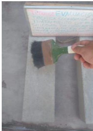
Figura N° 23 Preparación de la superficie
