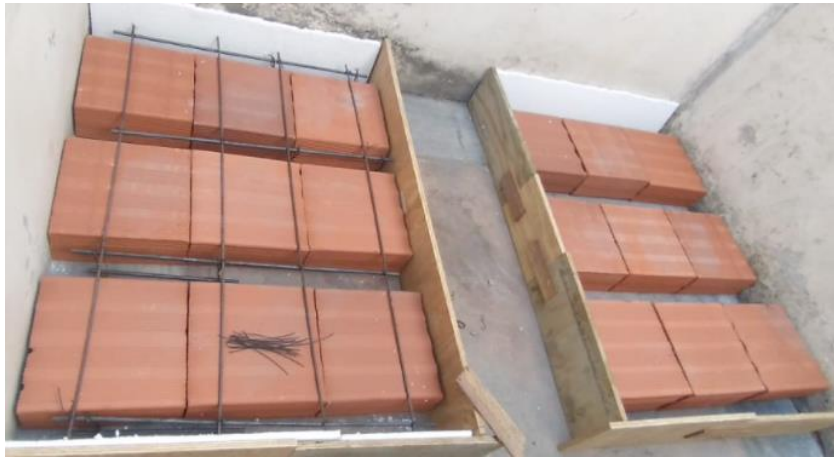
Figura N° 10 Encofrado para especímenes tipo losa aligerada
