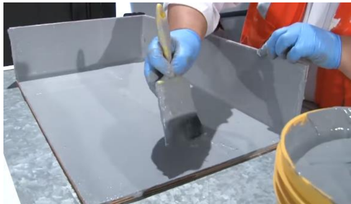
Figura N° 6 Aplicación membrana líquida
