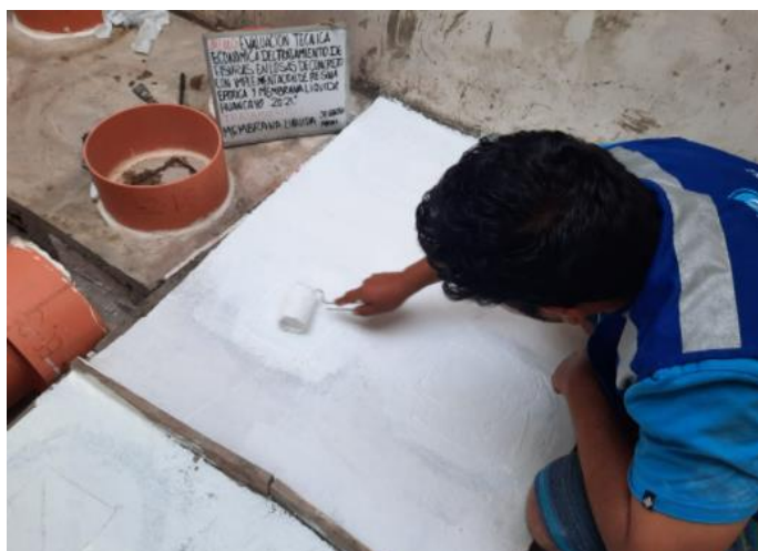
Figura N° 32 Tratamiento 2da mano con Membrana Líquida (Sikalastic 560)
