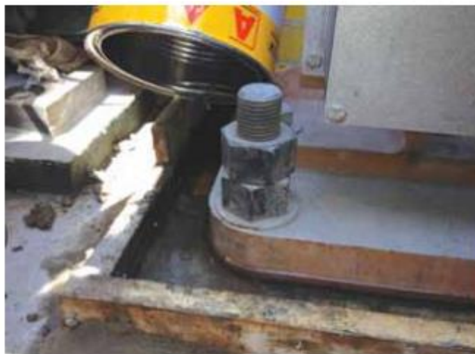
Figura N° 5 Aplicación resina epóxica por gravedad
