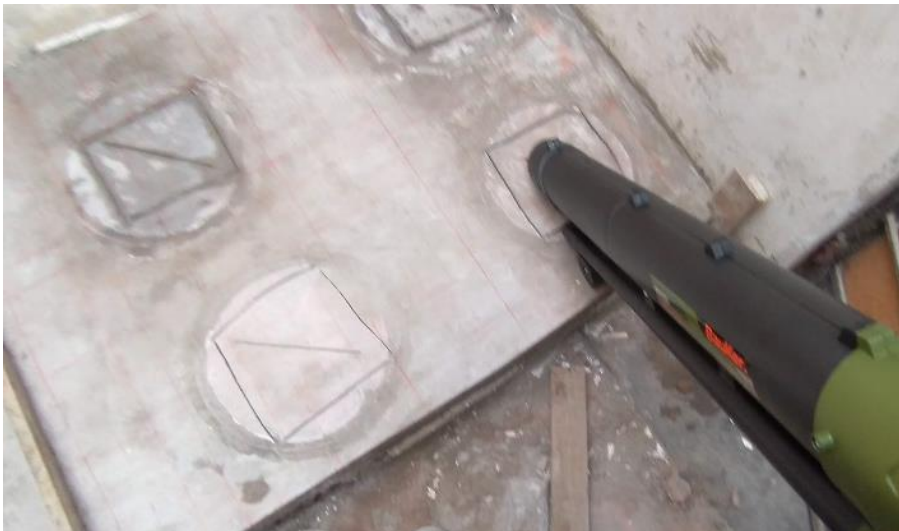
Figura N° 29 Limpieza y preparación de la superficie
