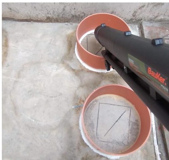
Figura N° 33 Limpieza y preparación de la superficie
