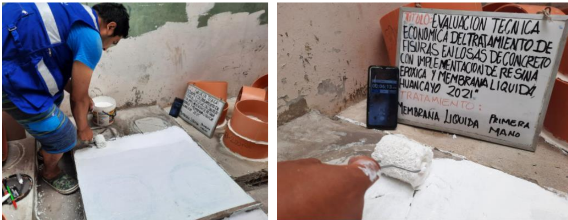
Figura N° 31 Tratamiento 1ra mano con Membrana Líquida (Sikalastic 560)
