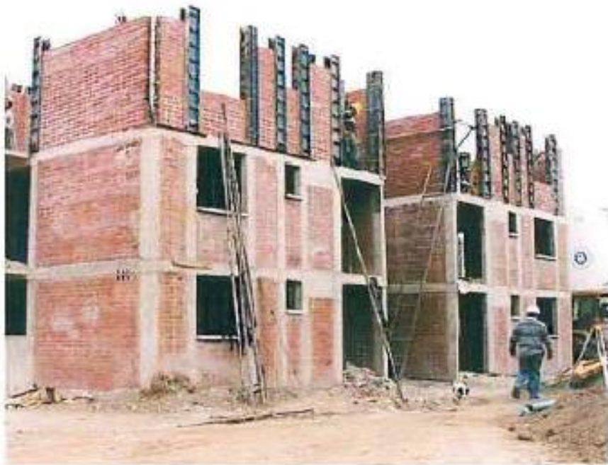
Figura 3: Albañilería confinada
